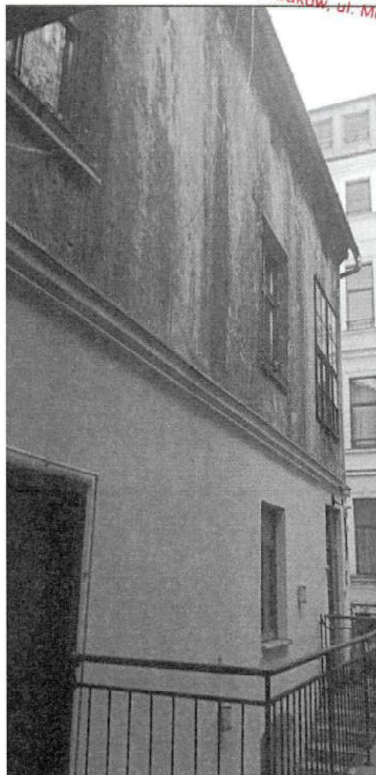
15 i 16 – widok elewacji dobudówki przy tylnej elewacji budynku oraz elewacji oficyny. Widać duży zakres zniszczeń tynków, które są odspojone, osłabione i silnie zabrudzone. W przypadku dobudówki widoczna jest dylatacja pomiędzy dobudówką a murem sąsiadującej kamienicy, która wydaje się poszerzać w sposób niekontrolowany.
