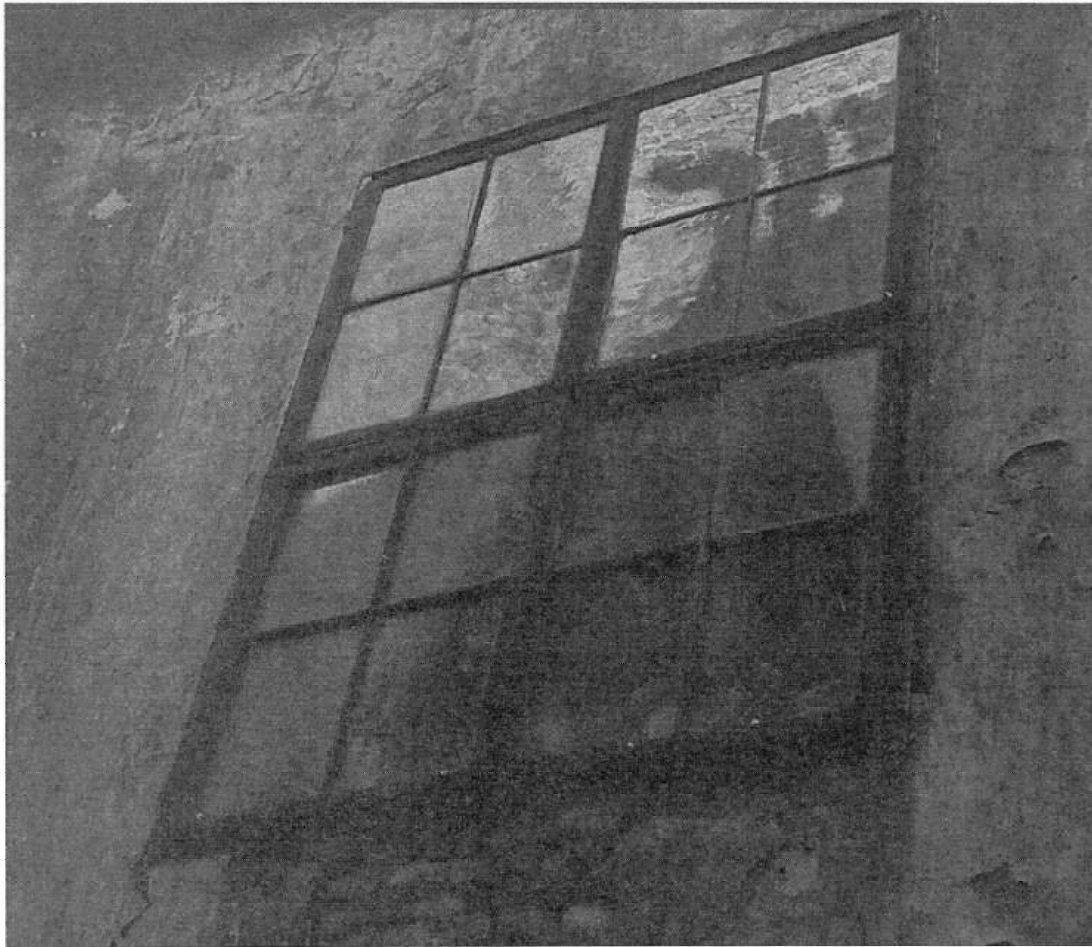
20 okno w elewacji oficyny bocznej
