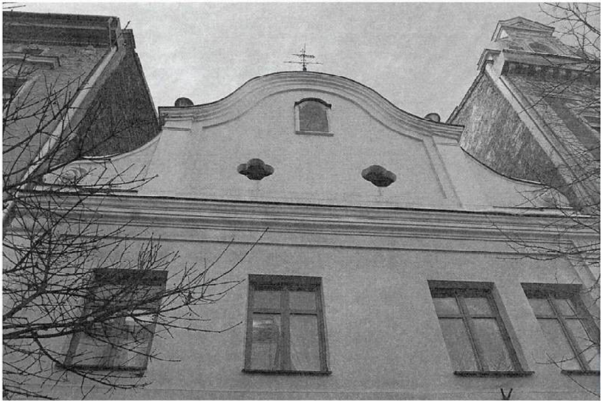
7. Elewacja frontowa, górne partie tynków - jak się wydaje zachowane w dobrym stanie, bez widocznych spękań i odspojień. Stan zachowania tynków w tej partii jest generalnie dobry.
