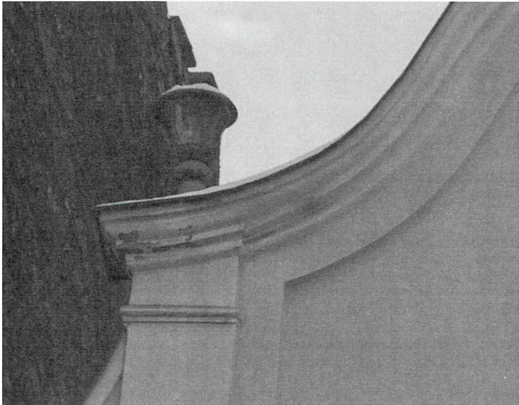
13. W górnych partiach elewacji, w obrębie gzymsu zaczynają być widoczne zaplamienia oraz odspajanie się warstwy malarskiej. Może to wynikać z nieszczelności obróbek blacharskich na gzymsie.
