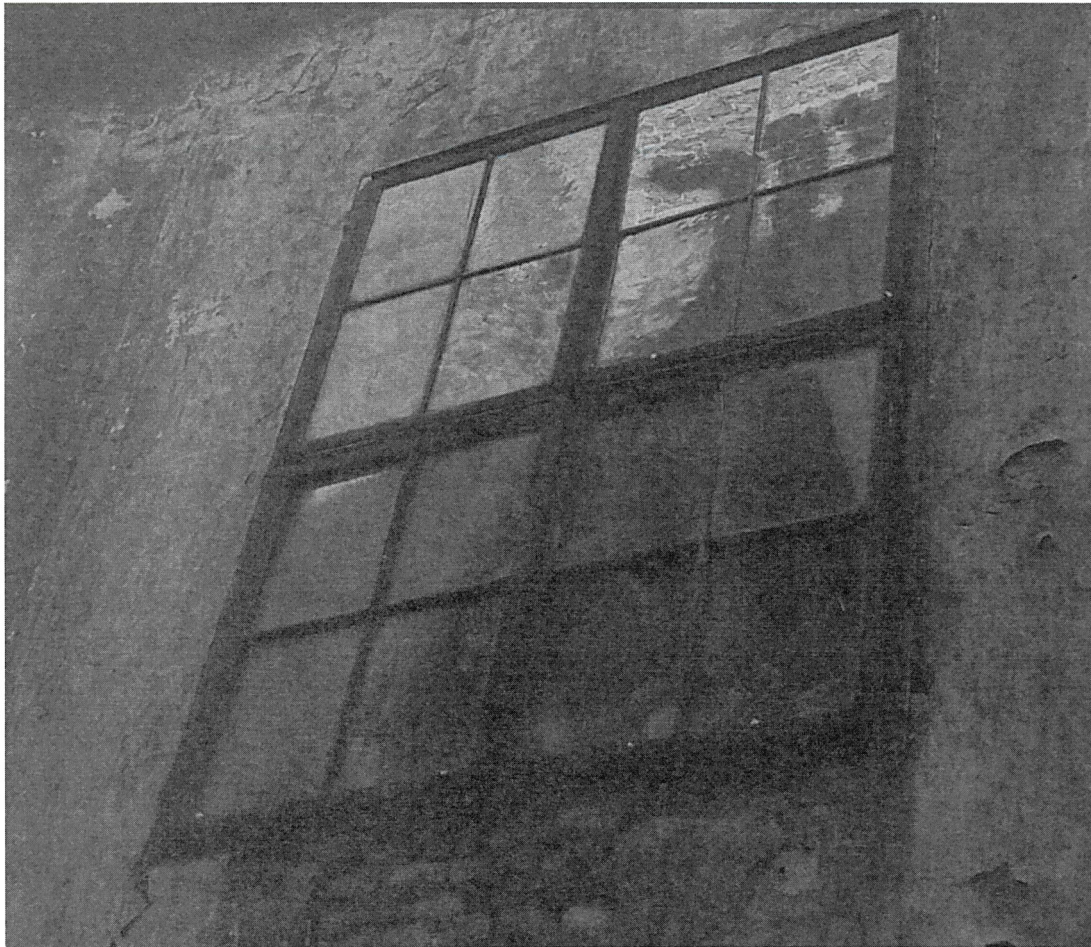
20 okno w elewacji oficyny bocznej
