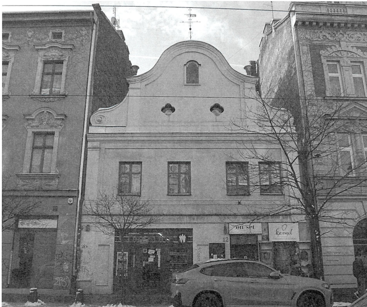
3. Elewacja frontowa budynku – widok ogólny
