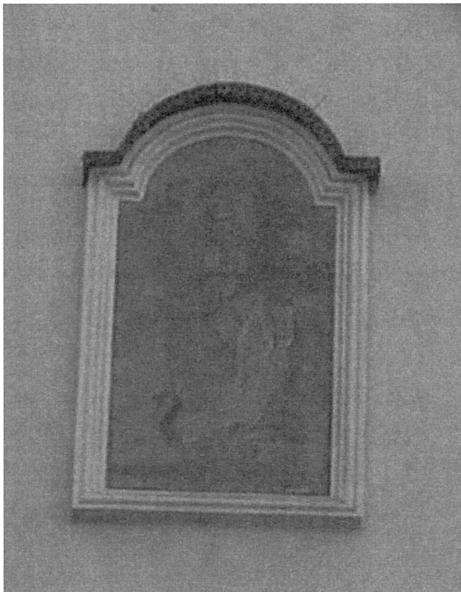
13. W górnych partiach elewacji, w obrębie gzymsu zaczynają być widoczne zaplamienia oraz odspajanie się warstwy malarskiej. Może to wynikać z nieszczelności obróbek blacharskich na gzymsie.
