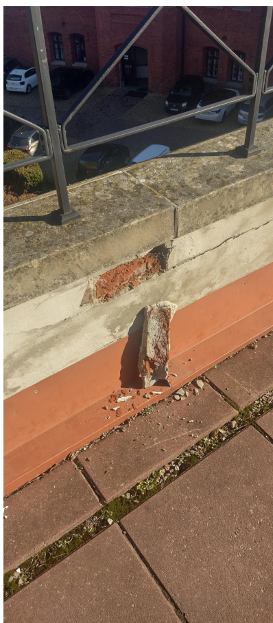
DEGRADACJA MURÓW Z CEGŁY , WYPRAW TYNKARSKICH , ZNISZCZENIE NAKRYW PIASKOWCOWYCH ORAZ ZMURSZENIA KAMIENIA COKŁOWEGO (PRACE WYKONYWANE W 1994 /5 ROKU )
