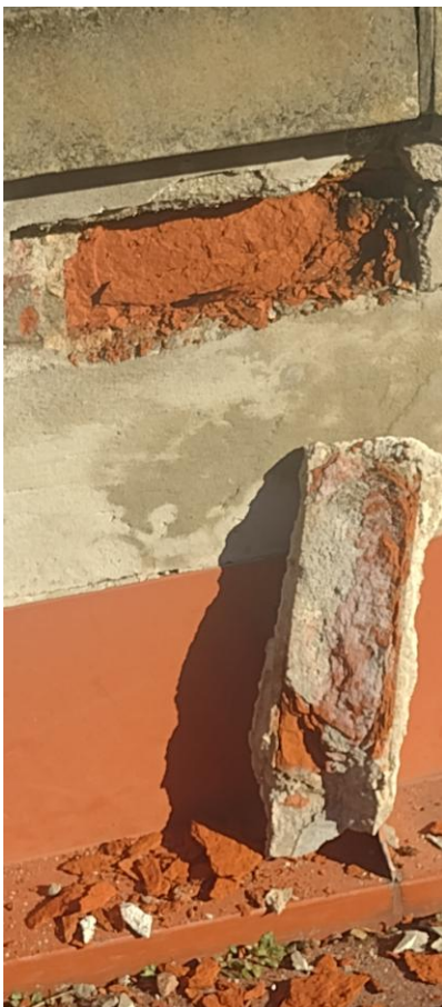
DEGRADACJA MURÓW Z CEGŁY , WYPRAW TYNKARSKICH , ZNISZCZENIE NAKRYW PIASKOWCOWYCH ORAZ ZMURSZENIA KAMIENIA COKŁOWEGO (PRACE WYKONYWANE W 1994 /5 ROKU )
