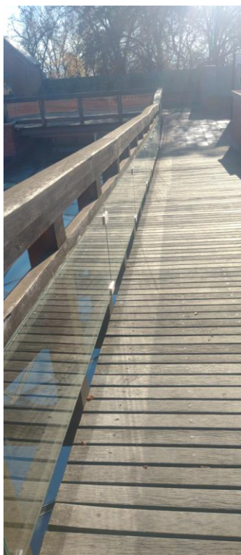
WIDOCZNE DESTRUKCJE MATERIAŁOWE PODESTU I BALUSTRADY
