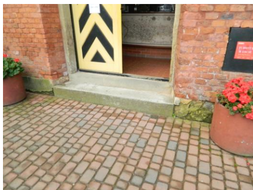
WIDOCZNE ŚLADY ZAWILGOCENIA ORAZ ZMURSZENIA CEGŁY I PIASKOWCA STAN TECHNICZNY SYFONÓW ŻELIWNÝCH -NIEZADOWALAJĄCY
