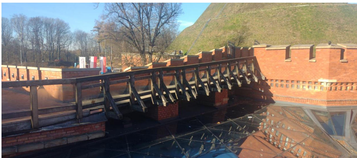
DREWNIANA KONSTRUKCJA POMOSTU
