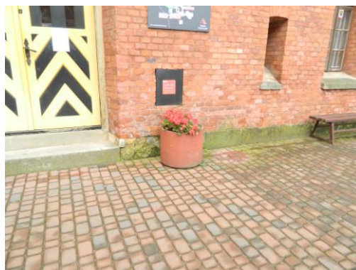
WIDOCZNE ŚLADY ZAWILGOCENIA ORAZ ZMURSZENIA CEGŁY I PIASKOWCA STAN TECHNICZNY SYFONÓW ŻELIWNÝCH -NIEZADOWALAJĄCY
