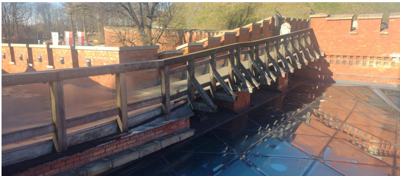
POMOST DREWNIANY ŁĄCZĄCY BASTION V Z KAPONIERĄ WEWNĘTRZNĄ, POŁUDNIOWĄ
