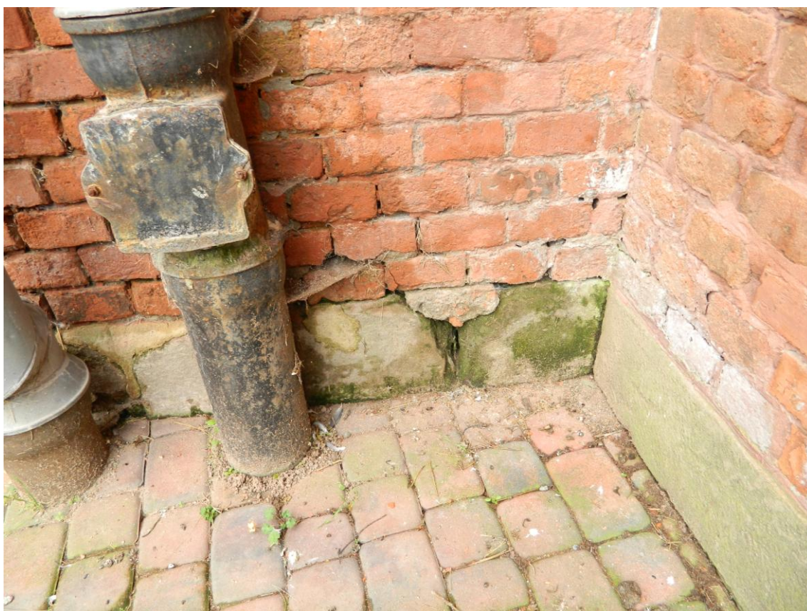
WIDOCZNE ŚLADY ZAWILGOCENIA ORAZ ZMURSZENIA CEGŁY I PIASKOWCA STAN TECHNICZNY SYFONÓW ŻELIWNÝCH -NIEZADOWALAJĄCY
