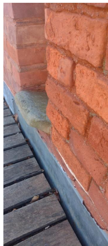
WIDOCZNE DESTRUKCJE MATERIAŁOWE PODESTU I BALUSTRADY
