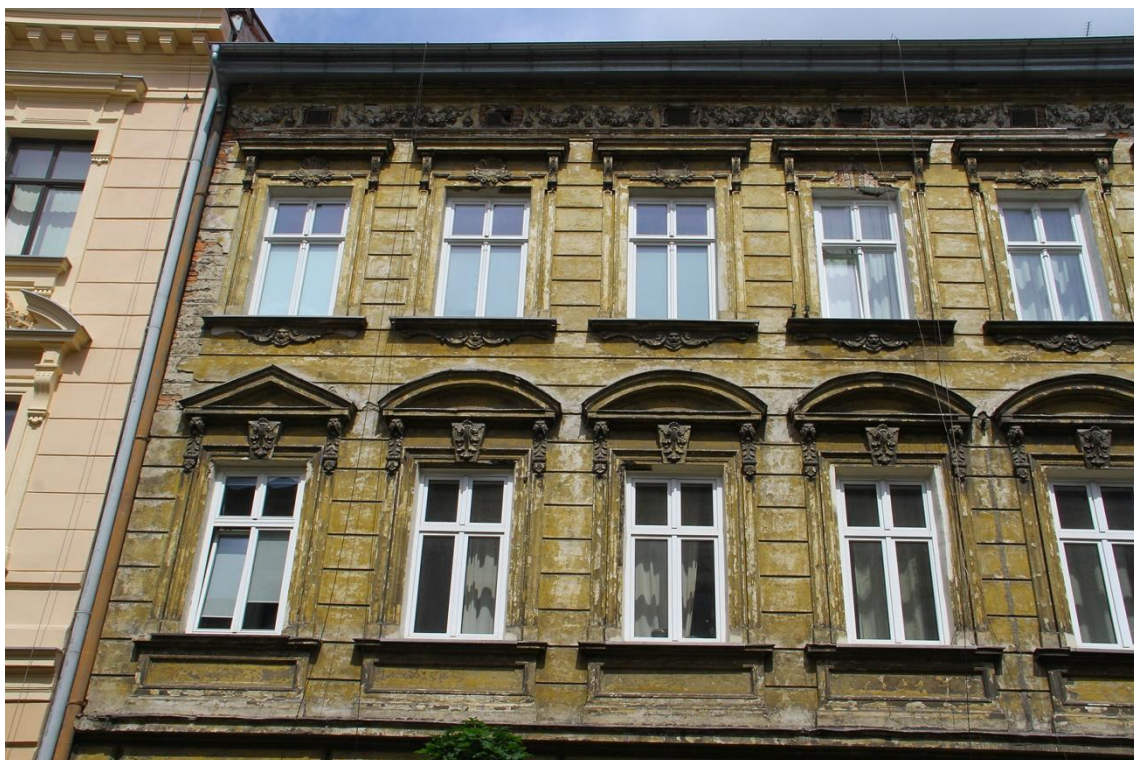
Fot.3 kamienica mieszkalna przy ul. michałowskiego 7 w Krakowie. Lewa strona górnych kondygnacji.
