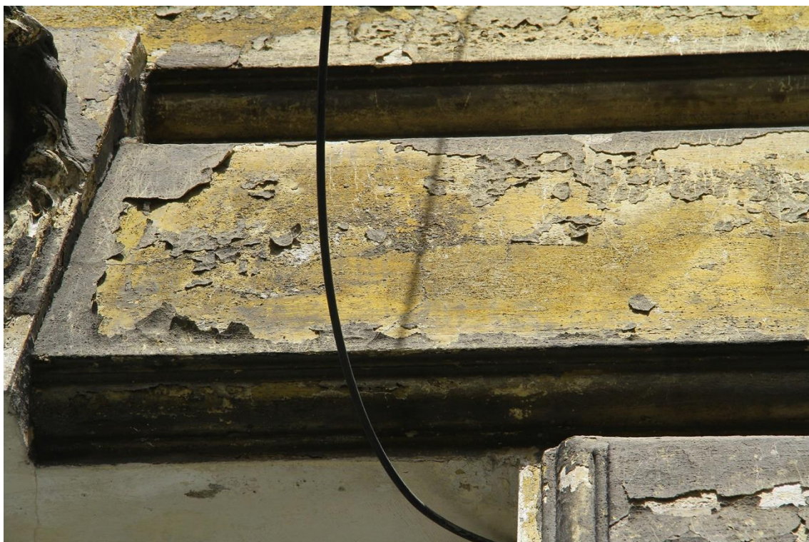
Fot.27 kamienica mieszkalna przy ul. Michałowskiego 7 w Krakowie. Prawdopodobna warstwa kolorystyki pierwotnej (najniższa), widoczna w odkrywce naturalnej, na powierzchni boniowania.
