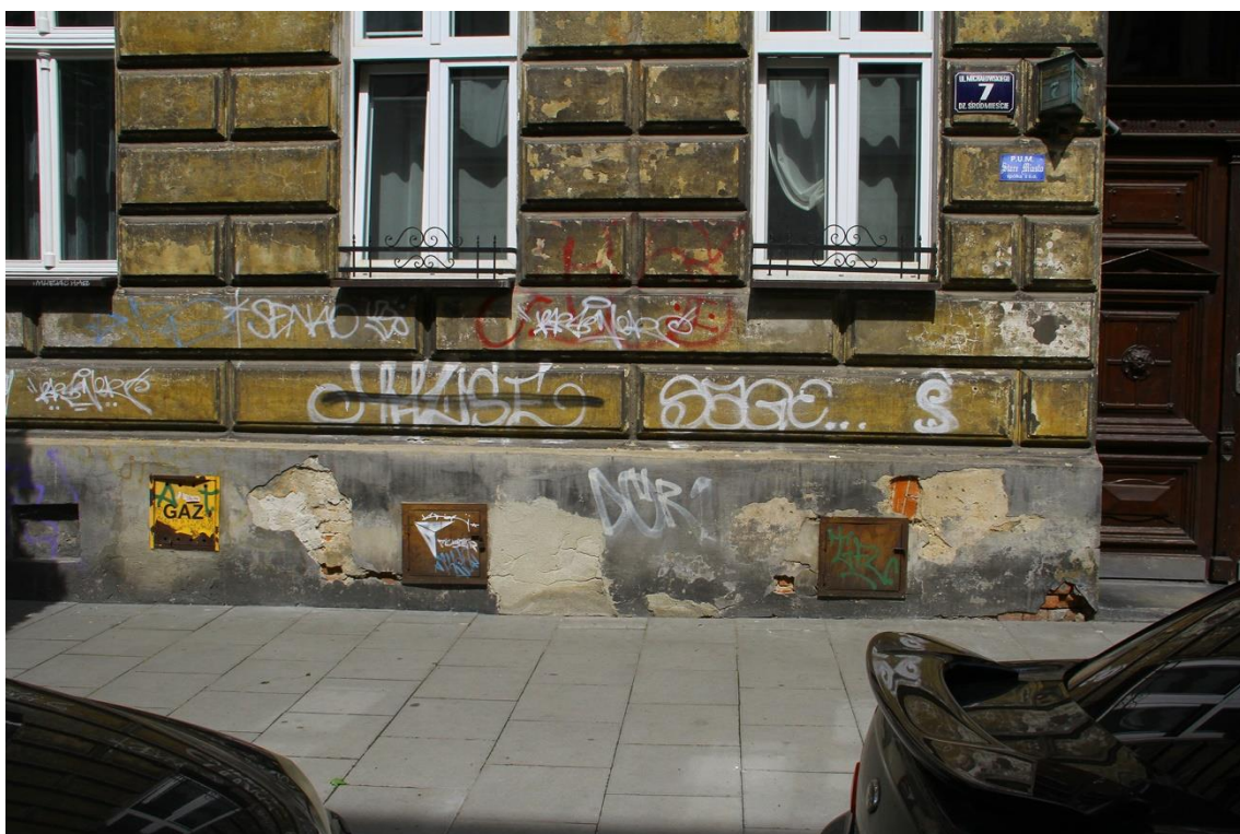
Fot.24 kamienica mieszkalna przy ul. Michałowskiego 7 w Krakowie. Cokół elewacji.
