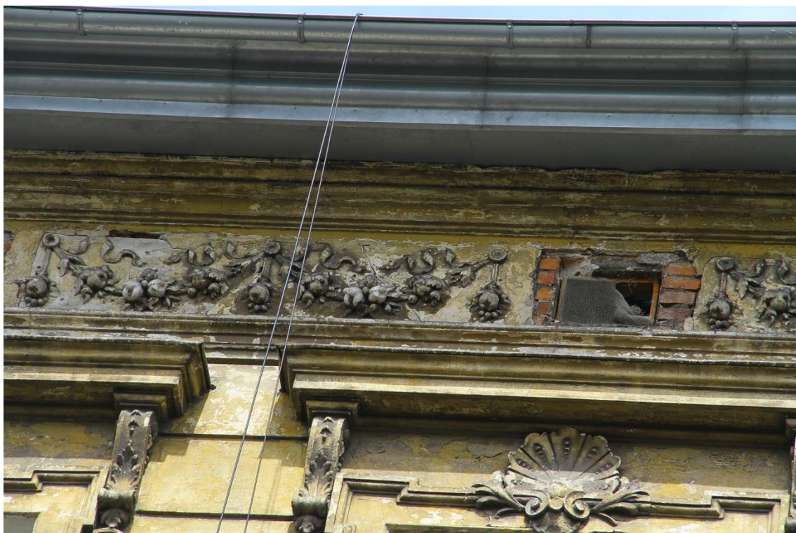
Fot.8 kamienica mieszkalna przy ul. Michałowskiego 7 w Krakowie. Ścianka kolankowa - fragment
