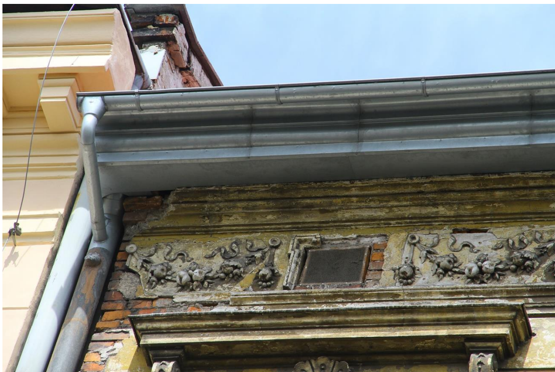
Fot.7 kamienica mieszkalna przy ul. Michałowskiego 7 w Krakowie. Ścianka kolankowa – fragment.
