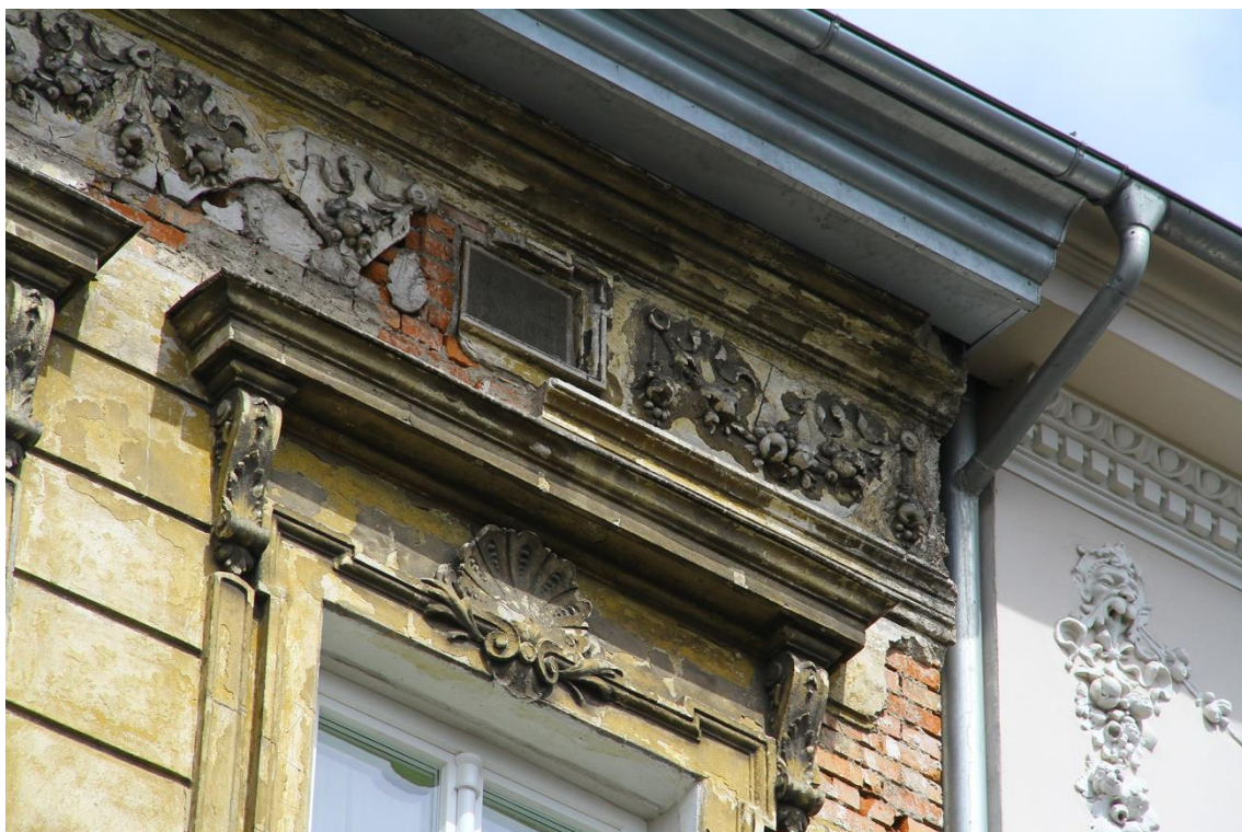
Fot.11 kamienica mieszkalna przy ul. Michałowskiego 7 w Krakowie. Ścianka kolankowa – fragment.
