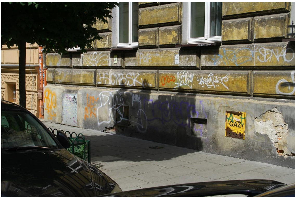
Fot.23 kamienica mieszkalna przy ul. Michałowskiego 7 w Krakowie. Cokół elewacji.
