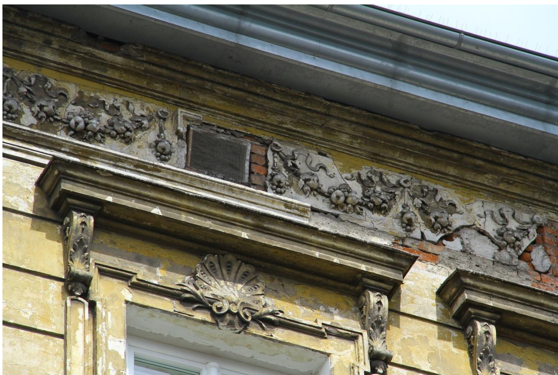
Fot.10 kamienica mieszkalna przy ul. Michałowskiego 7 w Krakowie. Ścianka kolankowa – fragment.
