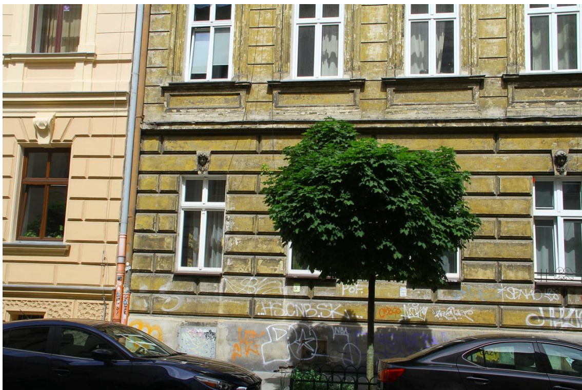
Fot.5 kamienica mieszkalna przy ul. Michałowskiego 7 w Krakowie. Lewa strona kondygnacji parteru.
