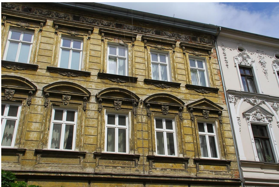
Fot.4 kamienica mieszkalna przy ul. michałowskiego 7 w Krakowie. Prawa strona górnych kondygnacji.
