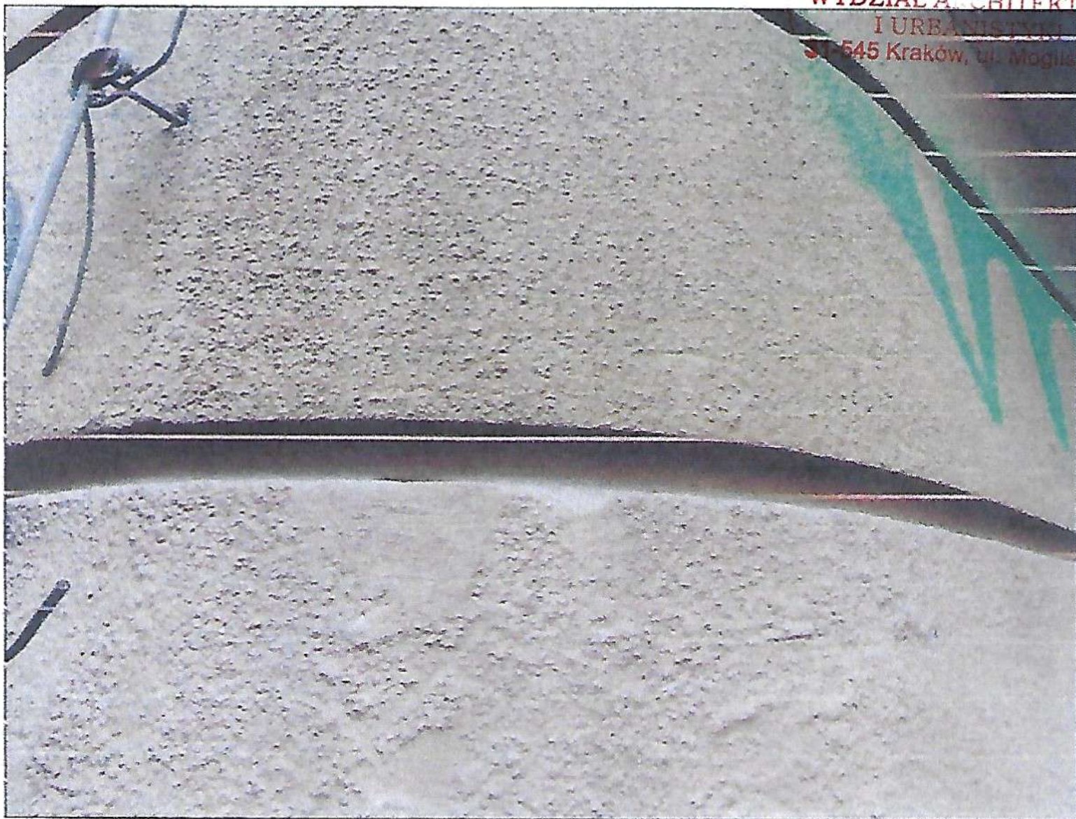
stan zachowania tynków na parterze, grube warstwy farb przemalowania zacierających charakter aranżacji elewacji budynku; uszkodzenia tynków wierzchnich i pokładowych na trzonach i bazach kolumn - rozległe liczne zaprawy naprawcze i przemalówki
