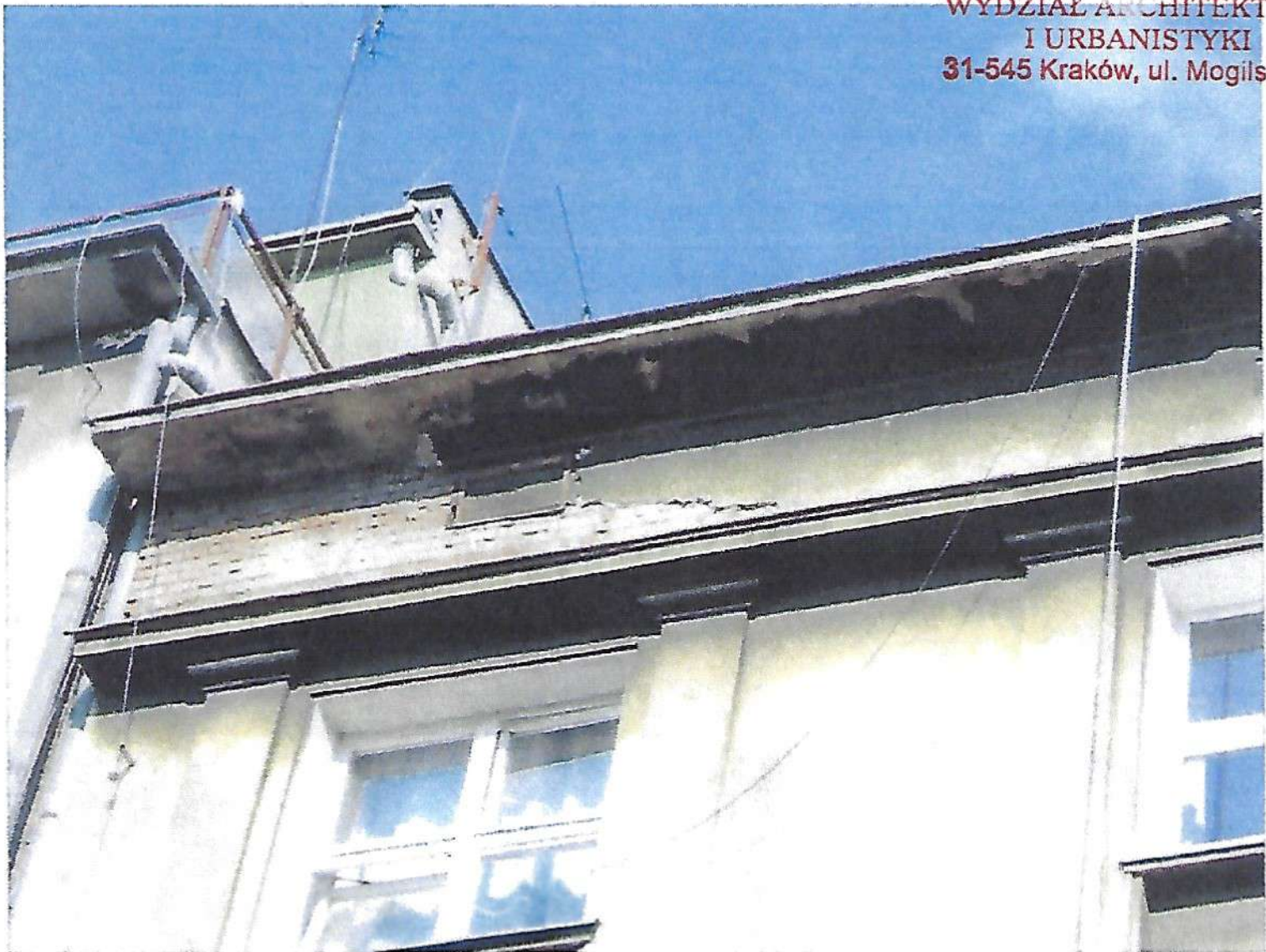
uszkodzenia obróbek powygdujące znaczne zniszczenia tynków w tym ubytki, spękania
