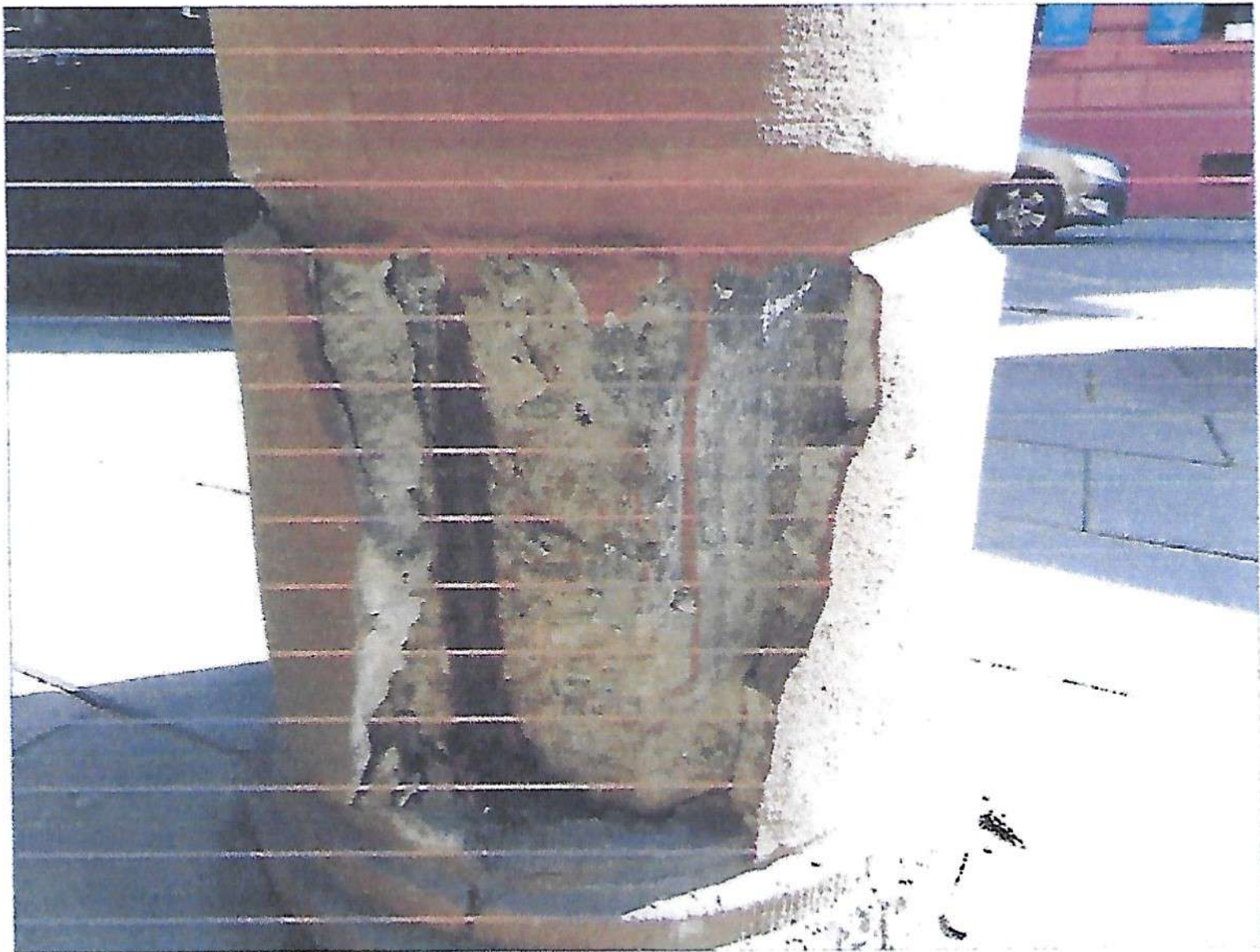
uszkodzenia tynków wierzchnich i pokładowych na trzonach bazach kolumn rozległe liczne zaprawy naprawcze i przemalówki; korozja stali zbrojeniowej
