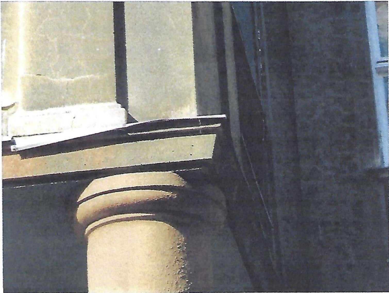
uszkodzenia obróbek powygdujące znaczne zniszczenia tynków w tym ubytki, spękania
