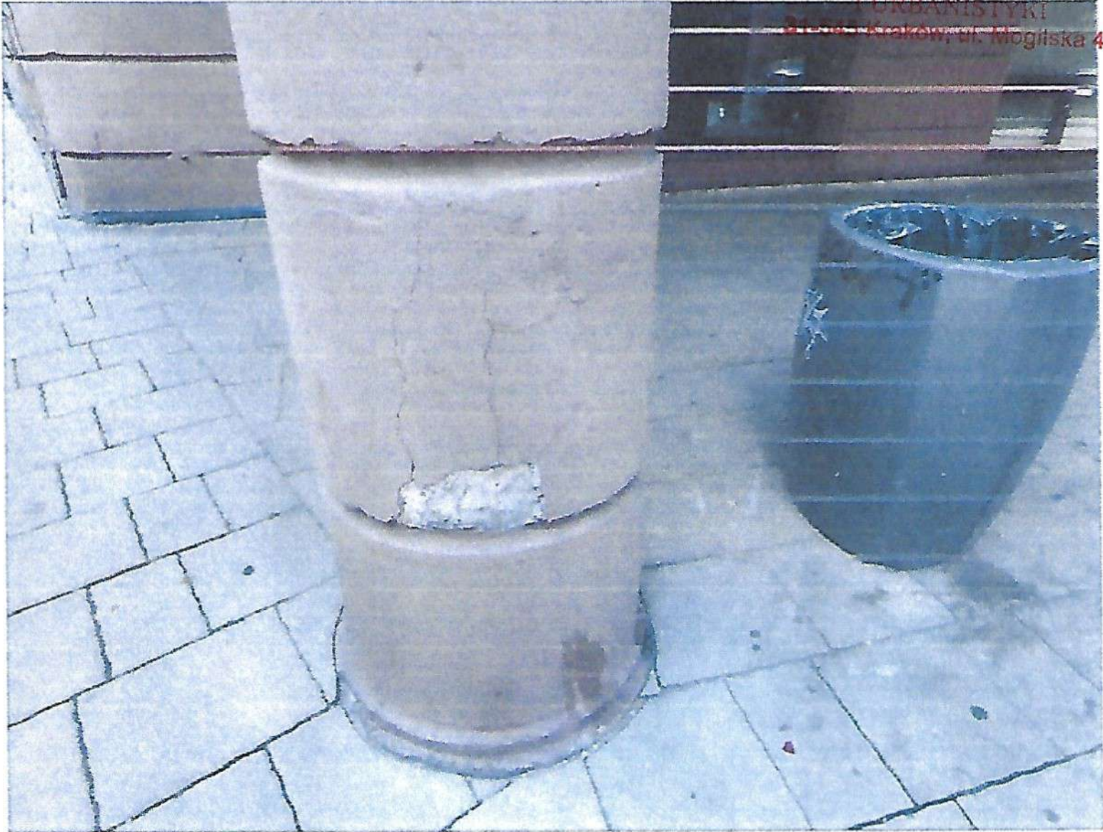
uszkodzenia tynków wierzchnich i pokładowych na trzonach bazach kolumn rozległe liczne zaprawy naprawcze i przemalówki; korozja stali zbrojeniowej
