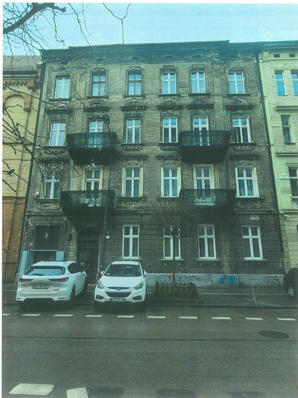
Fot 01. Kraków, ul. Sarego 25 – elewacja frontowa – stan zachowania.
