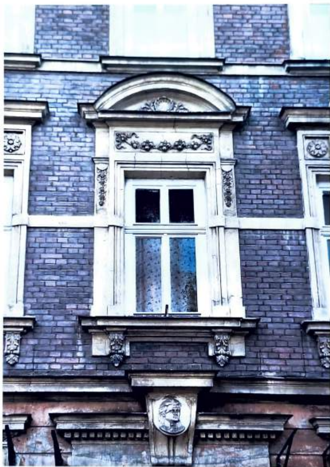
Fot. 3. Kamienica przy ul. Rejtana 8 w Krakowie. Elewacja frontowa, fragment. Widoczny ozdobny detal architektoniczny. Lipiec 2024 r.
