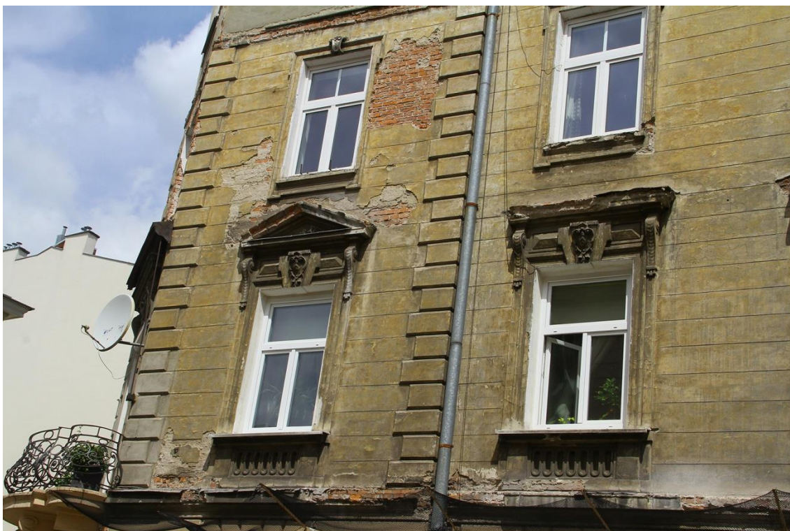
Fot. 14 kamienica mieszkalna przy ul. Studenckiej 29/Garncarska 10 w Krakowie. Elewacja od str. ul. Studenckiej – lewa strona pierwszego piętra.
