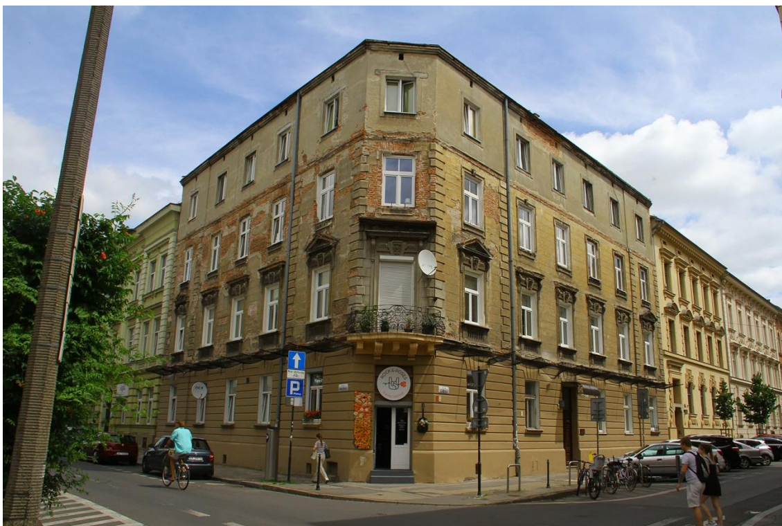
Fot. 1 kamienica mieszkalna przy ul. Studenckiej 29/Garncarska 10 w Krakowie. Obie elewacje – widok ogólny.
