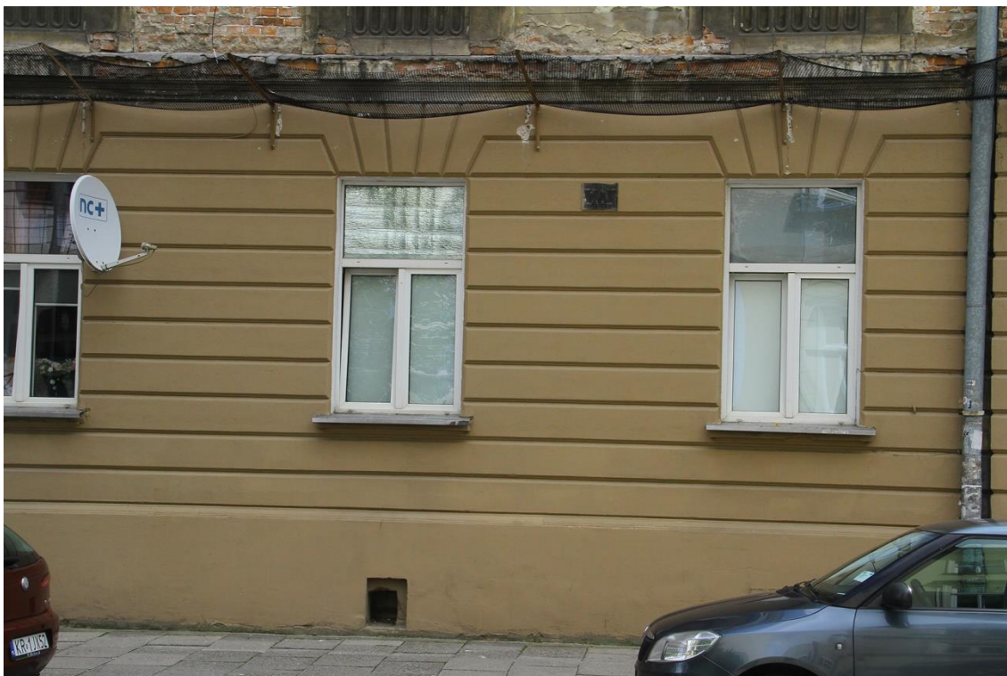
Fot. 9 kamienica mieszkalna przy ul. Studenckiej 29/Garncarska 10 w Krakowie. Elewacja od str. ul. Garncarskiej – środkowa część parteru.
