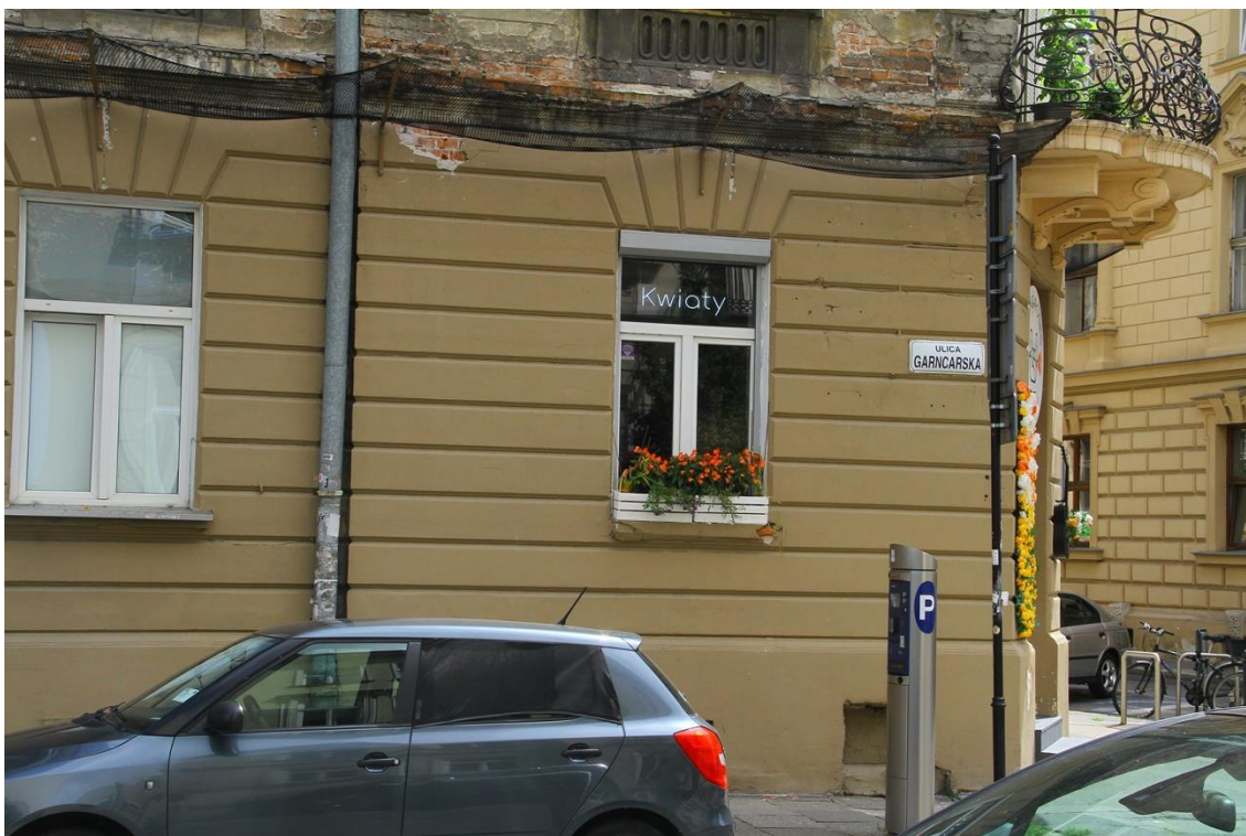
Fot. 10 kamienica mieszkalna przy ul. Studenckiej 29/Garncarska 10 w Krakowie. Elewacja od str. ul. Garncarskiej – prawa strona parteru.
