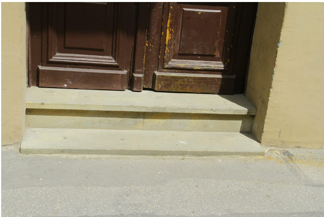
Fot. 29 kamienica mieszkalna przy ul. Studenckiej 29/Garncarska 10 w Krakowie. Drzwi wejściowe do budynku – stopnie wejścia.
