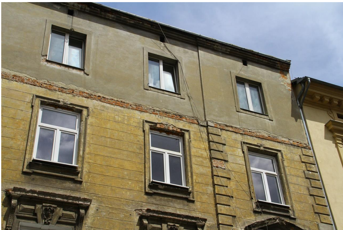
Fot. 13 kamienica mieszkalna przy ul. Studenckiej 29/Garncarska 10 w Krakowie. Elewacja od str. ul. Studenckiej – prawa strona trzeciego i drugiego piętra.
