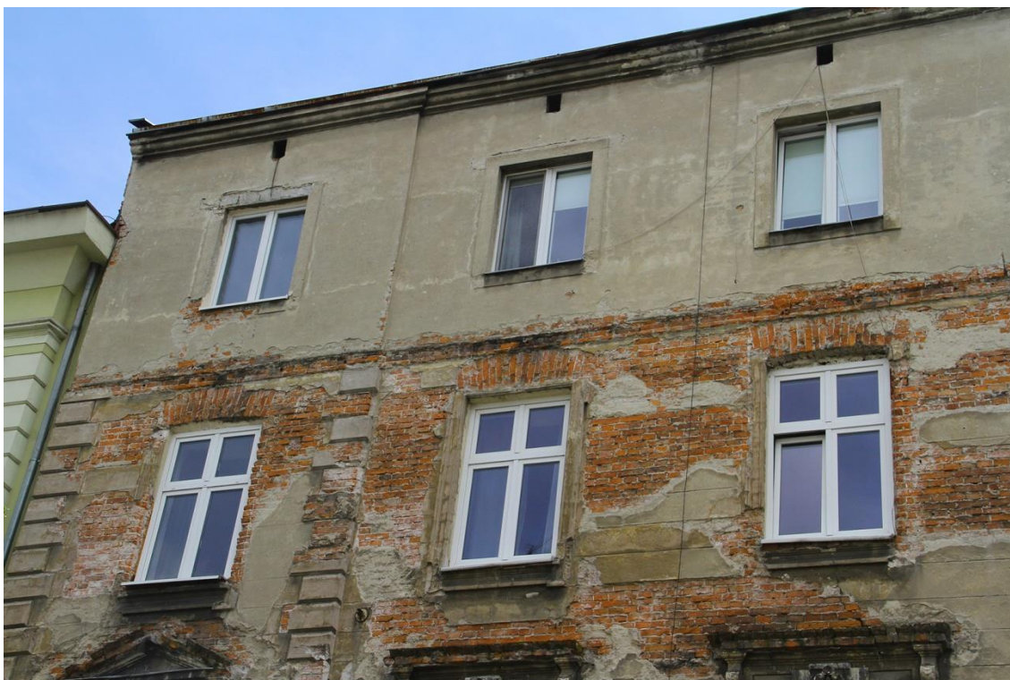
Fot. 2 kamienica mieszkalna przy ul. Studenckiej 29/Garncarska 10 w Krakowie. Elewacja od strony ul. Garncarskiej – lewa strona trzeciego i drugiego piętra.
