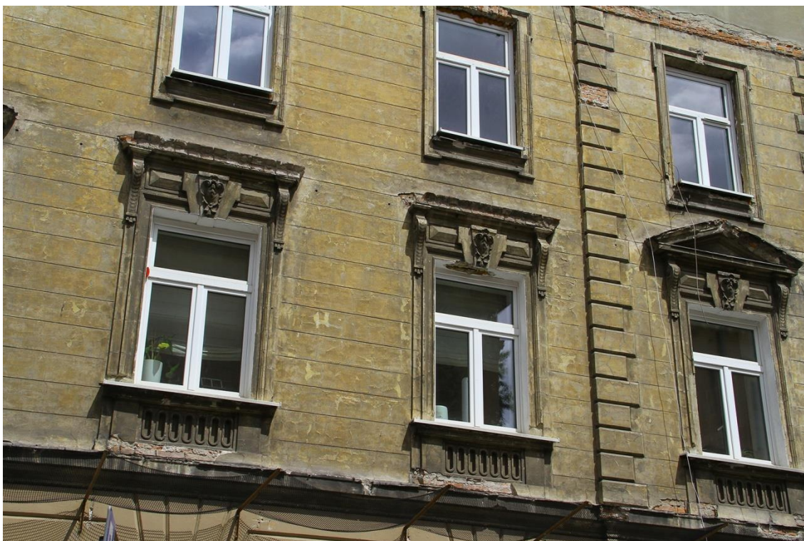
Fot. 16 kamienica mieszkalna przy ul. Studenckiej 29/Garncarska 10 w Krakowie. Elewacja od str. ul. Studenckiej – środkowa część pierwszego piętra (ciąg dalszy).
