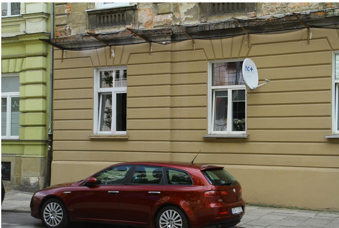
Fot. 8 kamienica mieszkalna przy ul. Studenckiej 29/Garncarska 10 w Krakowie. Elewacja od strony ul. Garncarskiej – lewa strona parteru.
