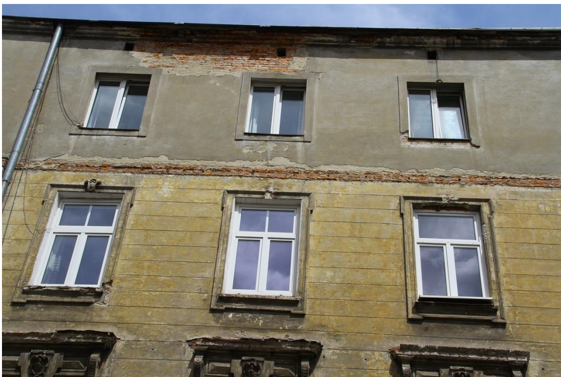
Fot. 12 kamienica mieszkalna przy ul. Studenckiej 29/Garncarska 10 w Krakowie. Elewacja od str. ul. Studenckiej – środkowa część trzeciego i drugiego piętra.
