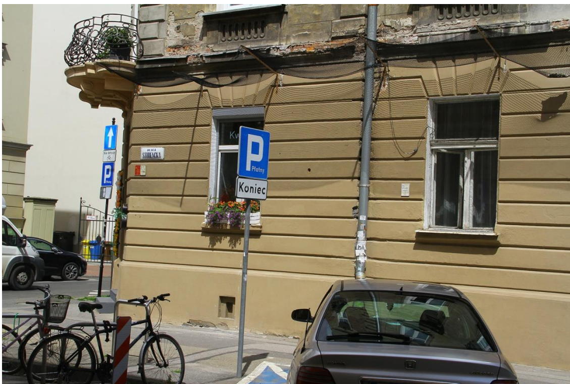
Fot. 18 kamienica mieszkalna przy ul. Studenckiej 29/Garncarska 10 w Krakowie. Elewacja od str. ul. Studenckiej – lewa strona parteru.
