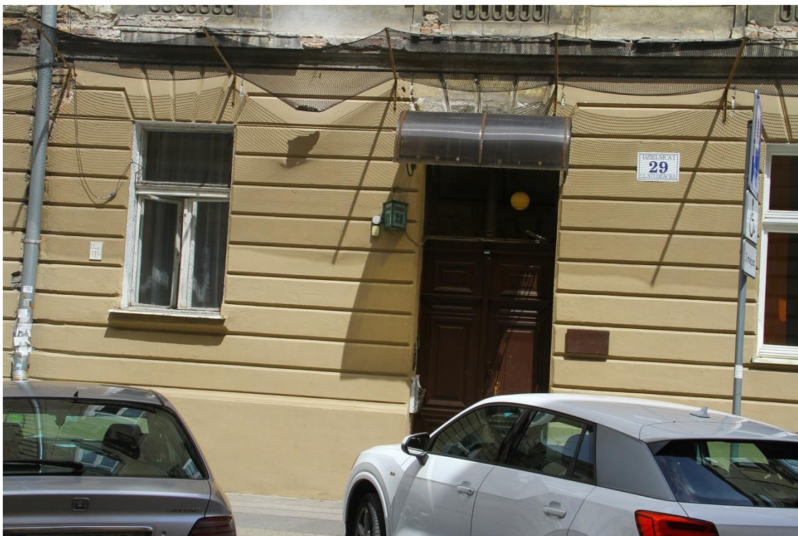
Fot. 19 kamienica mieszkalna przy ul. Studenckiej 29/Garncarska 10 w Krakowie. Elewacja od str. ul. Studenckiej – środkowa część parteru.
