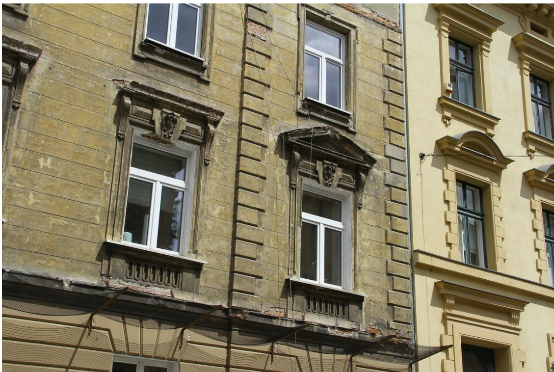
Fot. 17 kamienica mieszkalna przy ul. Studenckiej 29/Garncarska 10 w Krakowie. Elewacja od str. ul. Studenckiej – prawa strona pierwszego piętra.
