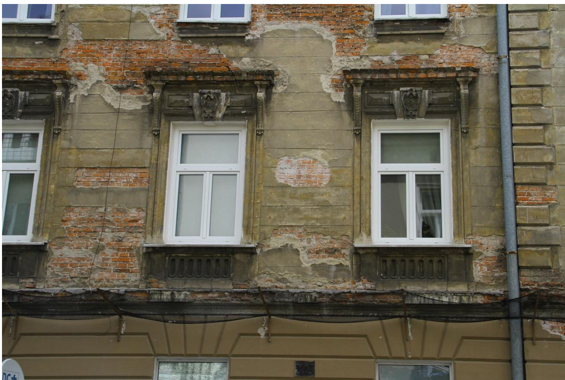
Fot. 6 kamienica mieszkalna przy ul. Studenckiej 29/Garncarska 10 w Krakowie. Elewacja od strony ul. Garncarskiej – środkowa część pierwszego piętra.
