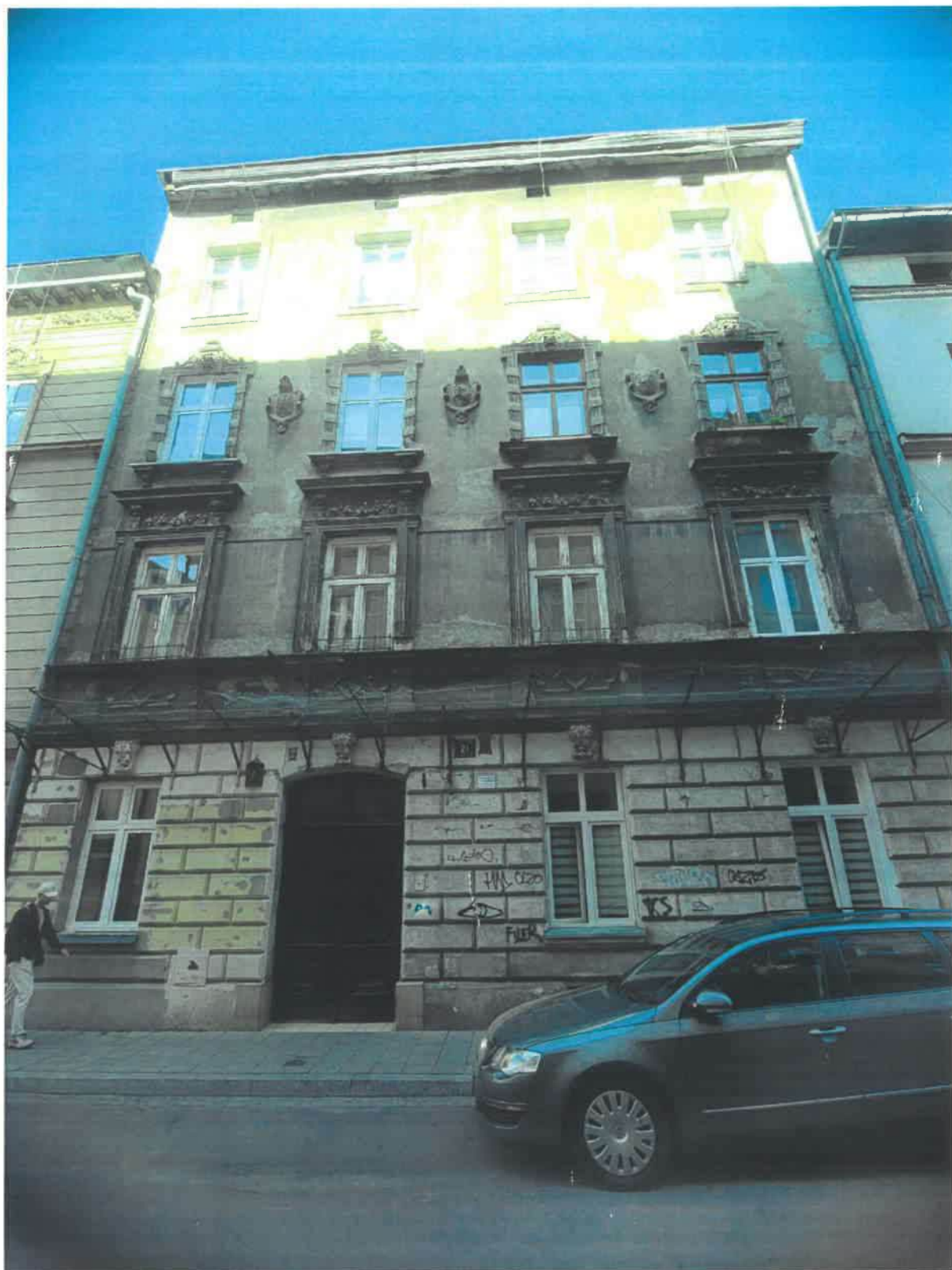
Fot 01. Kraków, ul. Felicjanek 21 – elewacja frontowa – stan zachowania.
