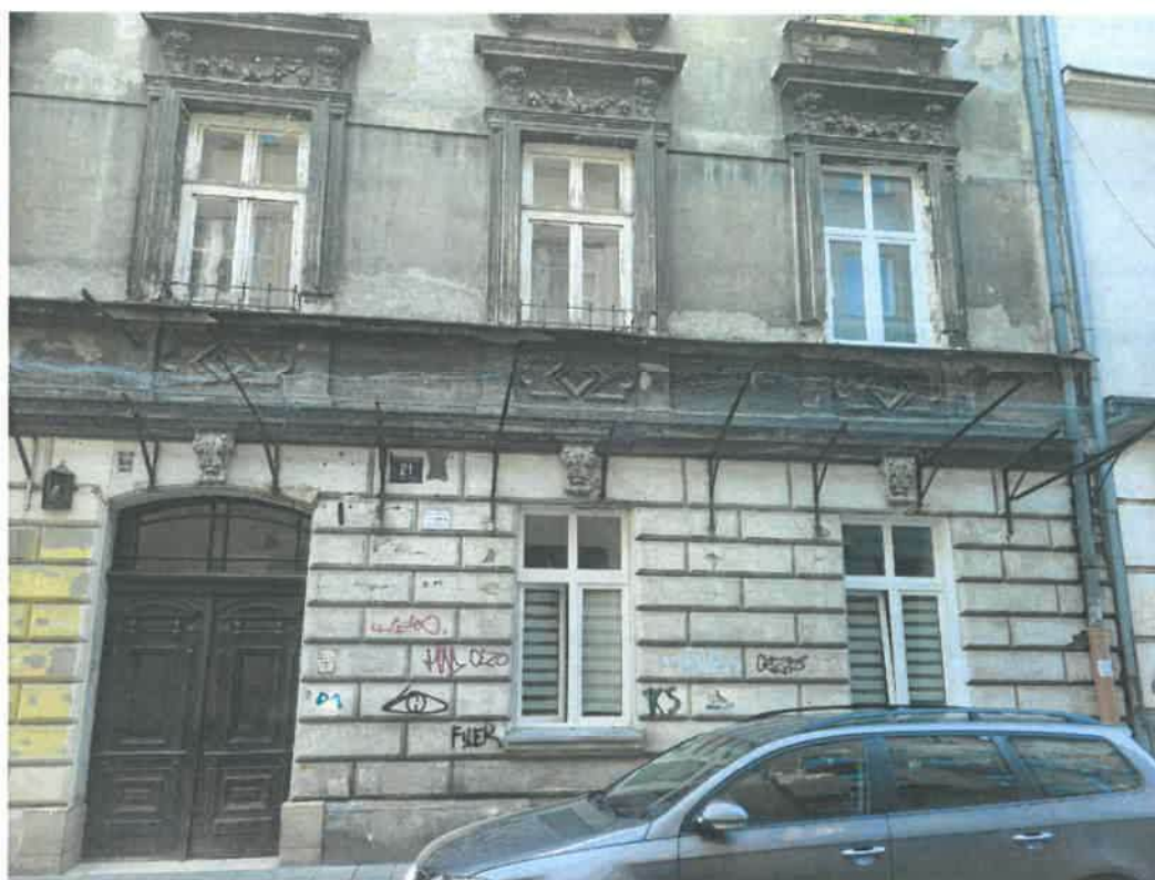
Fot 03. Kraków, ul. Felicjanek 21 – elewacja frontowa – stan zachowania.
