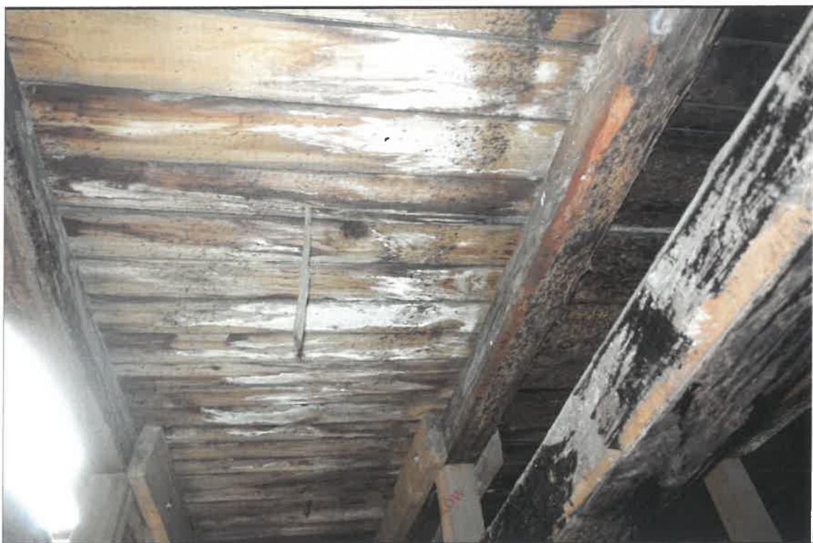
FOT. 14. KAMIENICA PRZY UL JÓZEFA 1 W KRAKOWIE Fragment więźby dachu z deskowaniem, stan przed konserwacją.
