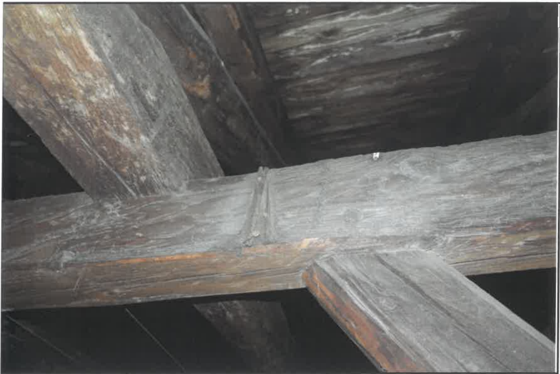
FOT. 15. KAMIENICA PRZY UL JÓZEFA 1 W KRAKOWIE Fragment więźby w miejscach połączeń belek, stan przed konserwacją.
