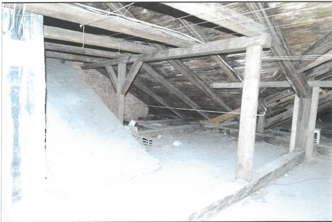
FOT. 9. KAMIENICA PRZY UL JÓZEFA 1 W KRAKOWIE
