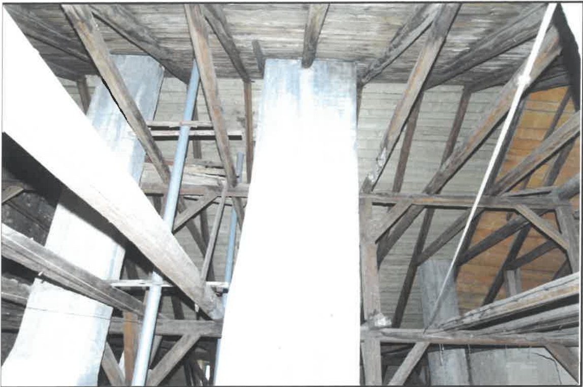
FOT. 7. KAMIENICA PRZY UL. JÓZEFA 1 W KRAKOWIE
