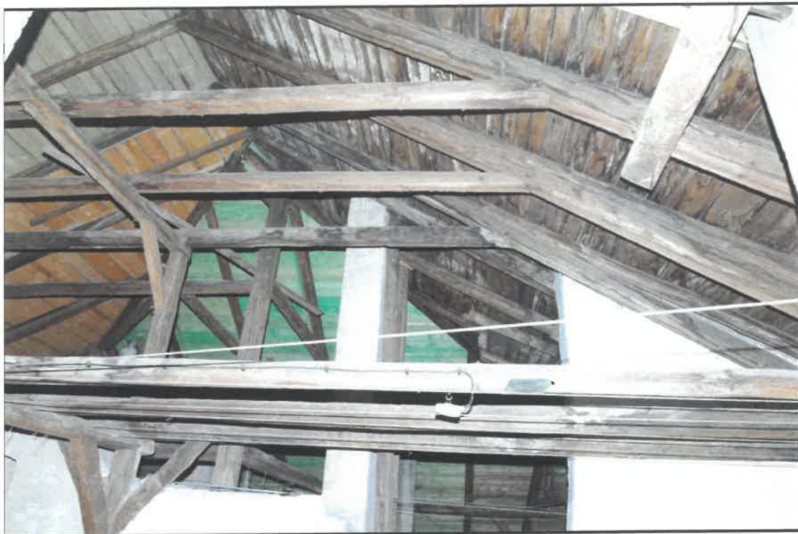
FOT. 3. KAMIENICA PRZY UL JÓZEFA 1 W KRAKOWIE Fragment więźby dachu, stan przed konserwacją.
