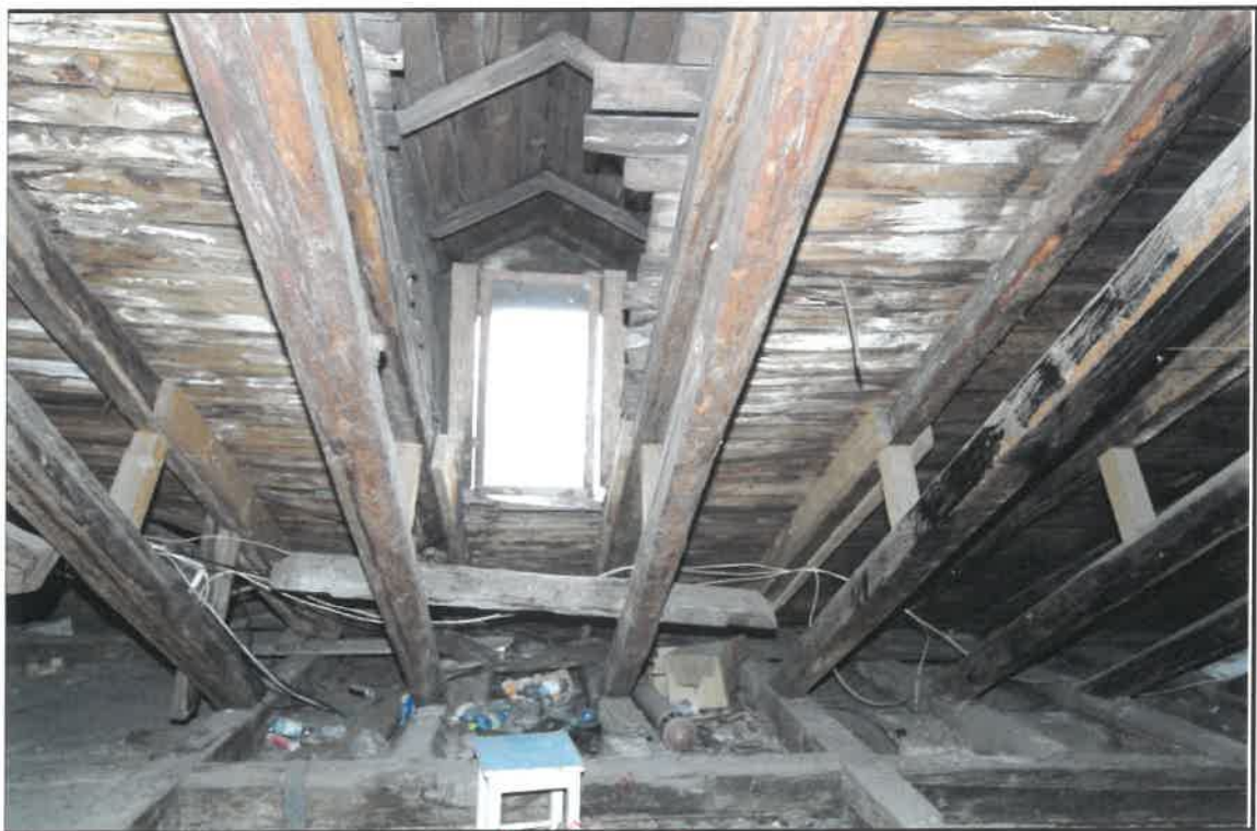
FOT. 8. KAMIENICA PRZY UL. JÓZEFA 1 W KRAKOWIE
