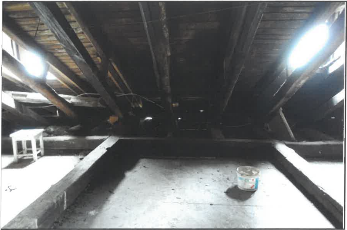
FOT. 29. KAMIENICA PRZY UL. JÓZEFA 1 W KRAKOWIE
