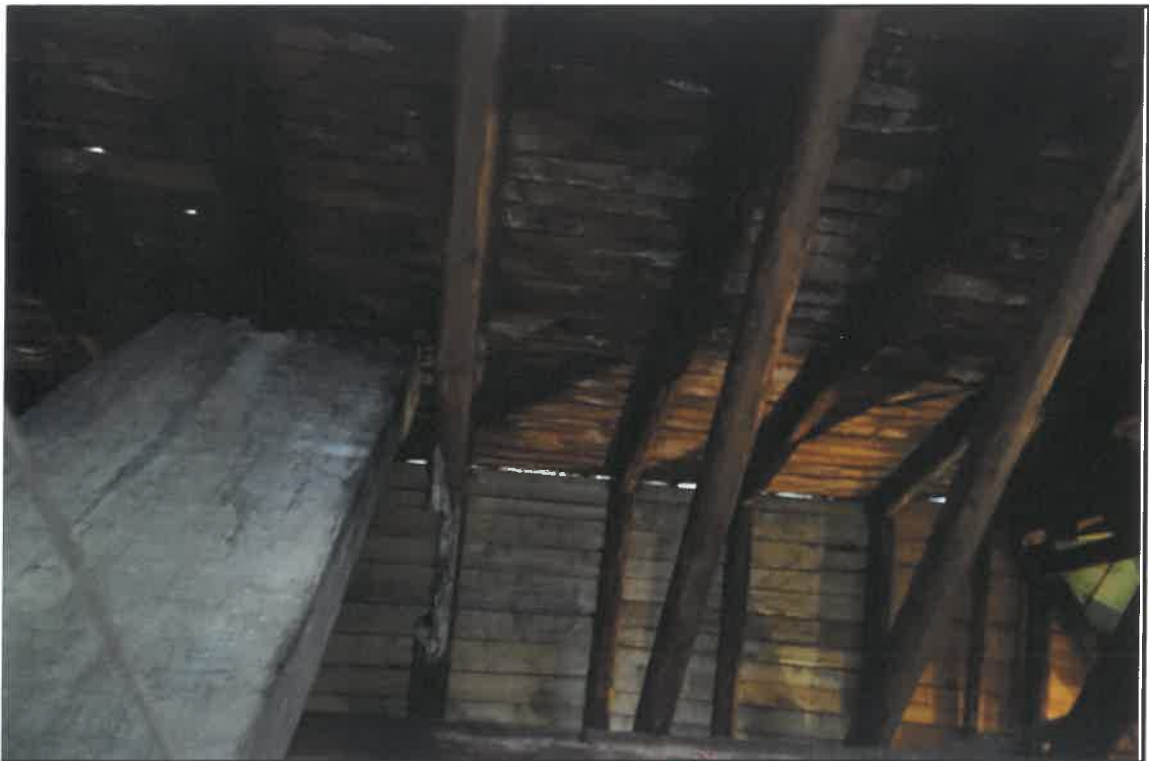
FOT. 30. KAMIENICA PRZY UL. JÓZEFA 1 W KRAKOWIE
