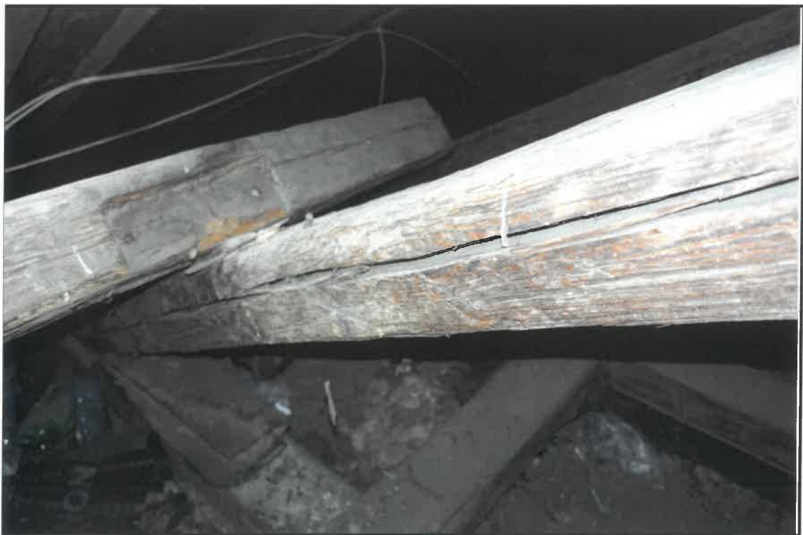
FOT. 15. KAMIENICA PRZY UL JÓZEFA 1 W KRAKOWIE Fragment więźby w miejscach połączeń belek, stan przed konserwacją.
