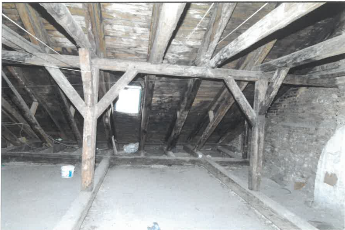
FOT. 5. KAMIENICA PRZY UL JÓZEFA 1 W KRAKOWIE Fragment więźby dachu, stan przed konserwacją.
