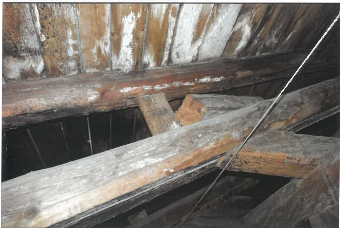
FOT. 26. KAMIENICA PRZY UL JÓZEFA 1 W KRAKOWIE Fragment więzby w miejscach połączeń belek, stan przed konserwacją.
