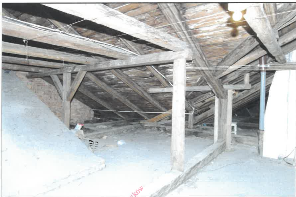
FOT. 6. KAMIENICA PRZY UL JÓZEFA 1 W KRAKOWIE Fragment więźby dachu, stan przed konserwacją.
