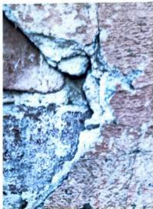
Fot.12.IV. Kamienica przy ul. Rejtana 8. Elewacja frontowa, fragment. Widoczny duży ubytek tynku do warstwy muru w partii boniowania.
