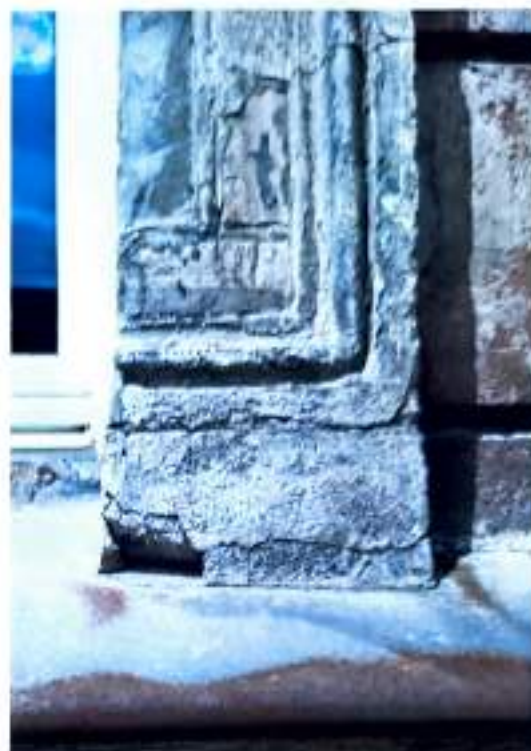
Fot.8.IV. Kamienica przy ul. Rejtana 8. Elewacja frontowa, fragment. Widoczny narożnik profilowanej opaski okiennej oraz fragment blaszanego parapetu. Powierzchnia detalu architektonicznego z wtórną, spękaną szlichtą, mocno zabrudzona. Parapet skrudowany.
