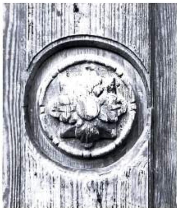
Fot.15.IV. Kamienica przy ul. Rejtana 8. Elewacja frontowa, fragment. Widoczny detal stolarki drzwi głównych.
