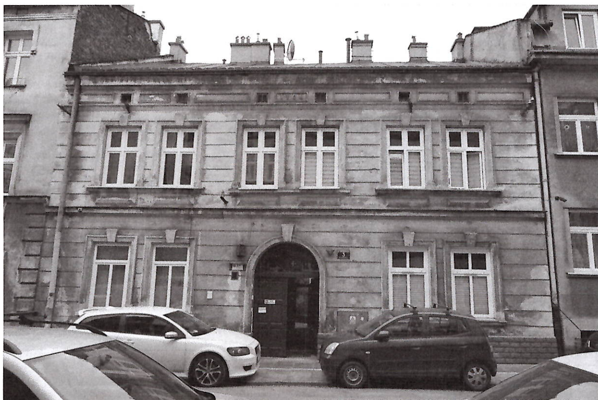
Kraków ul.Krasickiego 3 .Elewacja frontowa -widok ogólny. Stan przed konserwacją.
