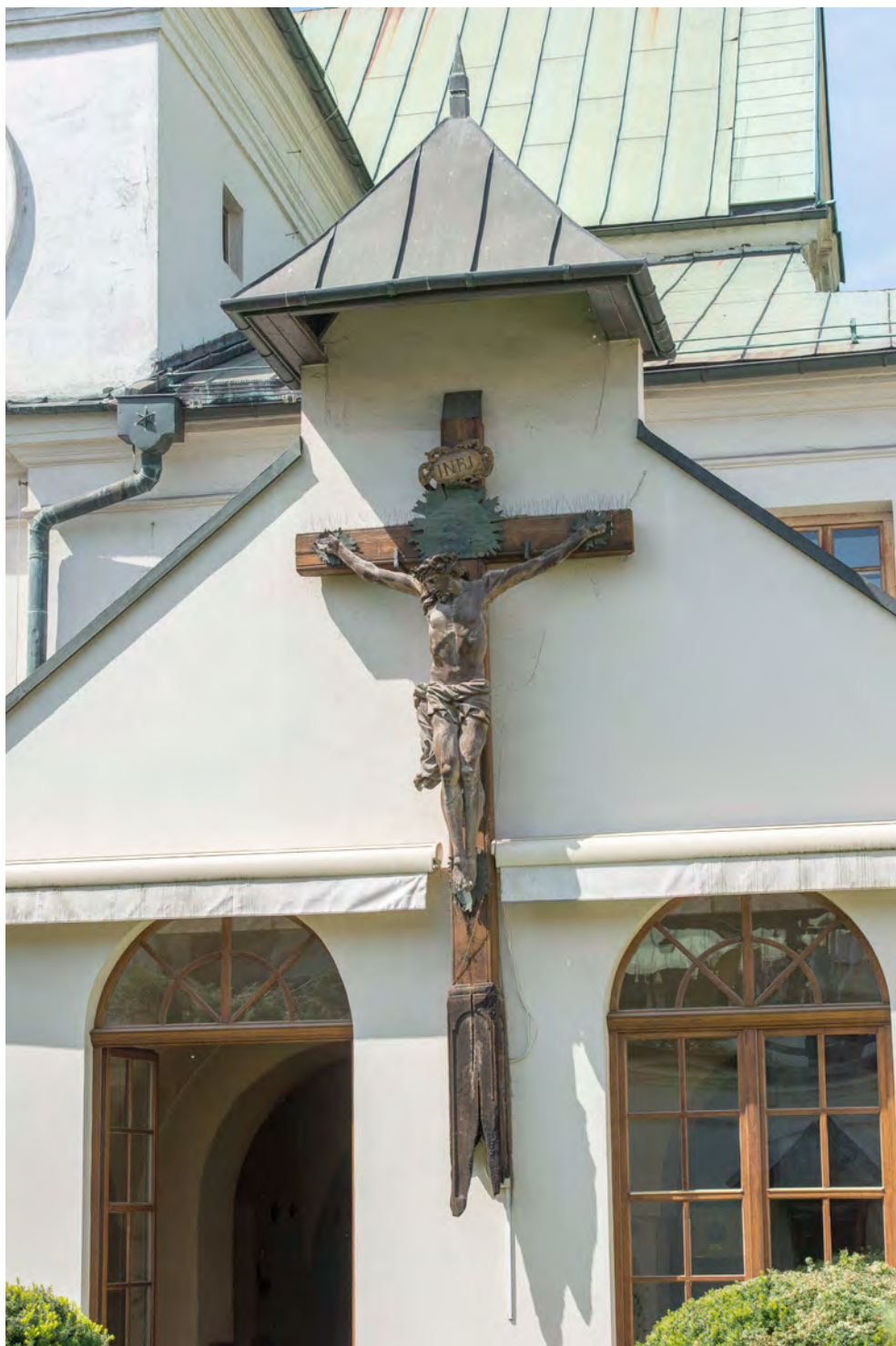
Fot. 35 Krucyfiks w wirydarzu, XVII/XVIII w. (?). Widoczne pęknięcia, zabrudzenia i oksydacja drewna, ślady polichromii w dolnej części krzyża, ubytki formy rzeźbiarskiej w obrębie dłoni Chrystusa oraz ubytki drewna podstawy krzyża.
