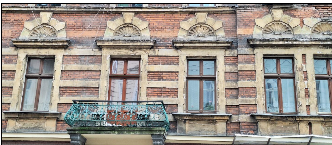
Fot. 5. KAMIENICA PRZY UL. STUDENCKIEJ 7 W KRAKOWIE. II kondygnacja., stan przed konserwacją. Marzec 2024 r.
