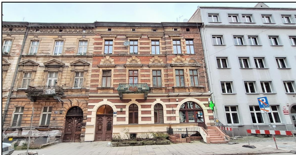
Fot. 1. KAMIENICA PRZY UL. STUDENCKIEJ 7 W KRAKOWIE. Ujęcie od str. pld., stan przed konserwacją. Marzec 2024 r.
