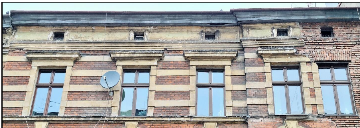
Fot. 4. KAMIENICA PRZY UL. STUDENCKIEJ 7 W KRAKOWIE. III kondygnacja., stan przed konserwacją. Marzec 2024 r.
