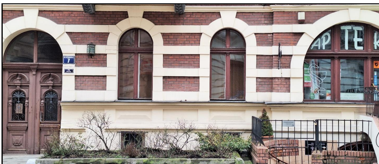
Fot. 6. KAMIENICA PRZY UL. STUDENCKIEJ 7 W KRAKOWIE. I kondygnacja., stan przed konserwacją. Marzec 2024 r.
