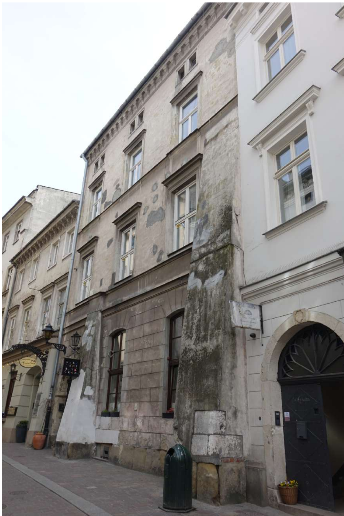
1. Kraków, fasada kamienicy przy ulicy Gołębiej 6. Widok ogólny, stan przed konserwacją.
