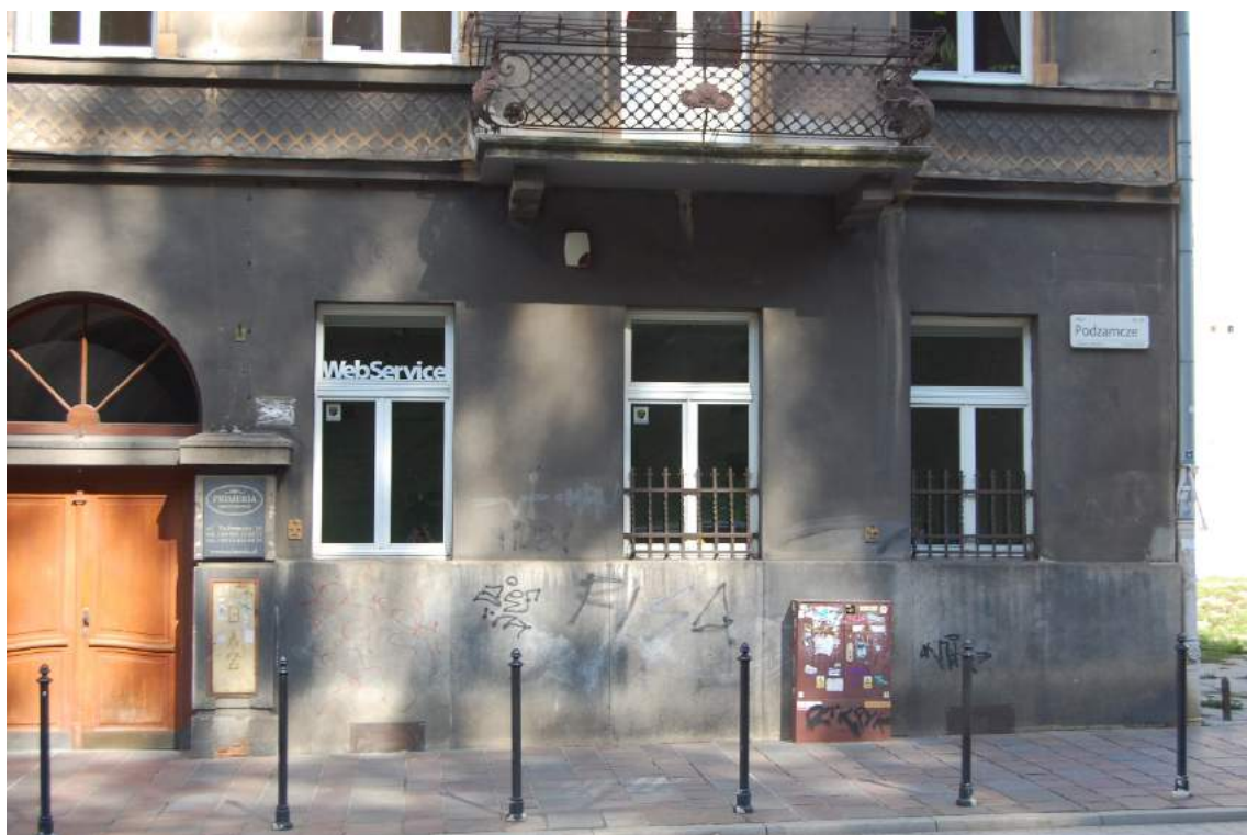
Widok ogólny elewacji. Widoczne zabrudzenie całej powierzchni, miejscowe wymycie powierzchni tynków przez spływającą wodę
