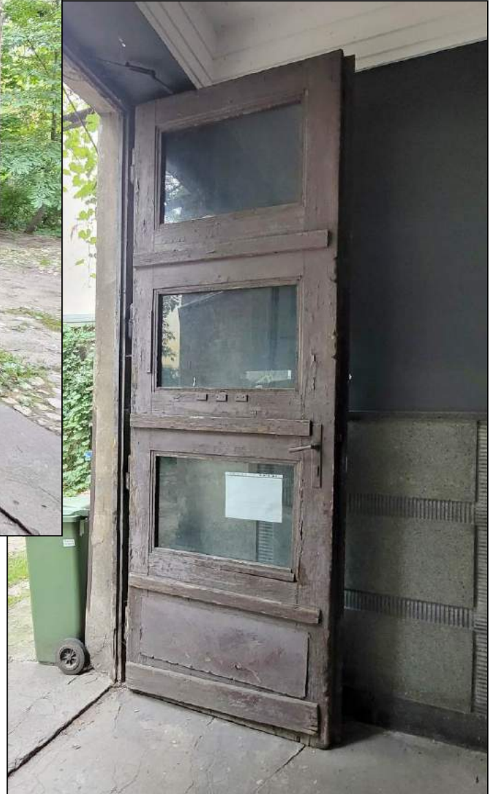
Fot. 33, 34 Kamienica przy ul. Krakowskiej 49, przejazd bramny , dwuskrzydłowa drewniana brama na podwórkę w złym stanie zachowania. Pozbawiona krat (jak brama wjazdowa), widoczne pozostałości po mocowaniu krat. Wrzesień 2022r. M. Wida
