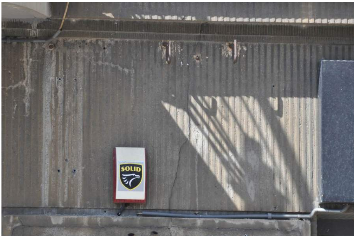
Fot. 19,20 Kamienica przy ul. Krakowskiej 49, fasada, fragment tynków pod gzymsem kordonowym parteru, po prawej stronie bramy. Tynk popękany z ubytkami, warstwą brudu, przekuty pod instalacje, haki itp. Wrzesień 2022r. M. Wida
