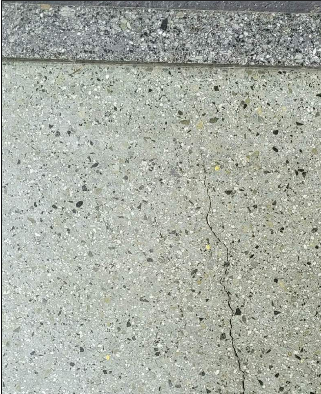
Fragment lastrika czarnego – listwa górna, fragment okładziny – element polerowany, widoczne ziarna kolorowych grysów marmurowych
