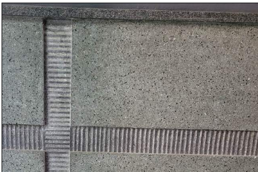
Fragment okładziny terazzo na ścianie pln.
