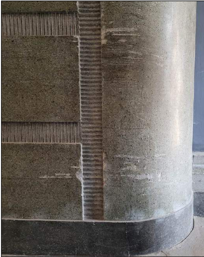
ubytki krawędziowe, przetarcia okładziny terazzo
