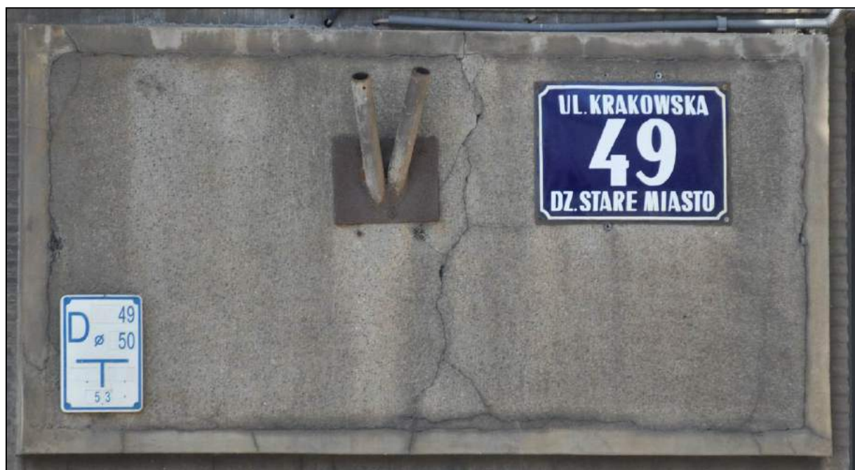
Fot. 19,20 Kamienica przy ul. Krakowskiej 49, fasada, fragment tynków pod gzymsem kordonowym parteru, po prawej stronie bramy. Tynk popękany z ubytkami, warstwą brudu, przekuty pod instalacje, haki itp. Wrzesień 2022r. M. Wida
