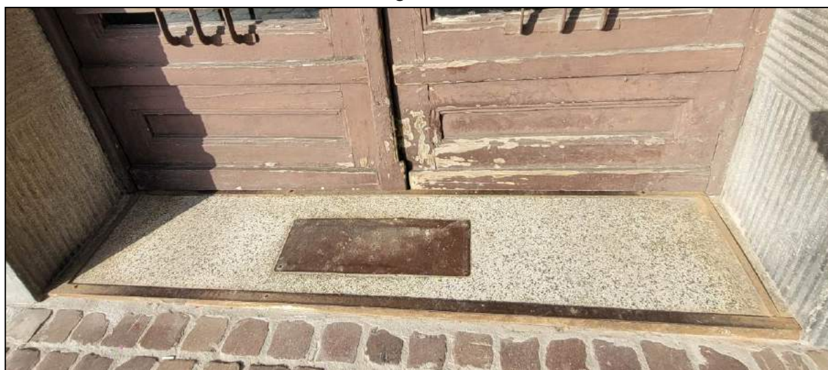
Fot.22, szczegół fot.21
