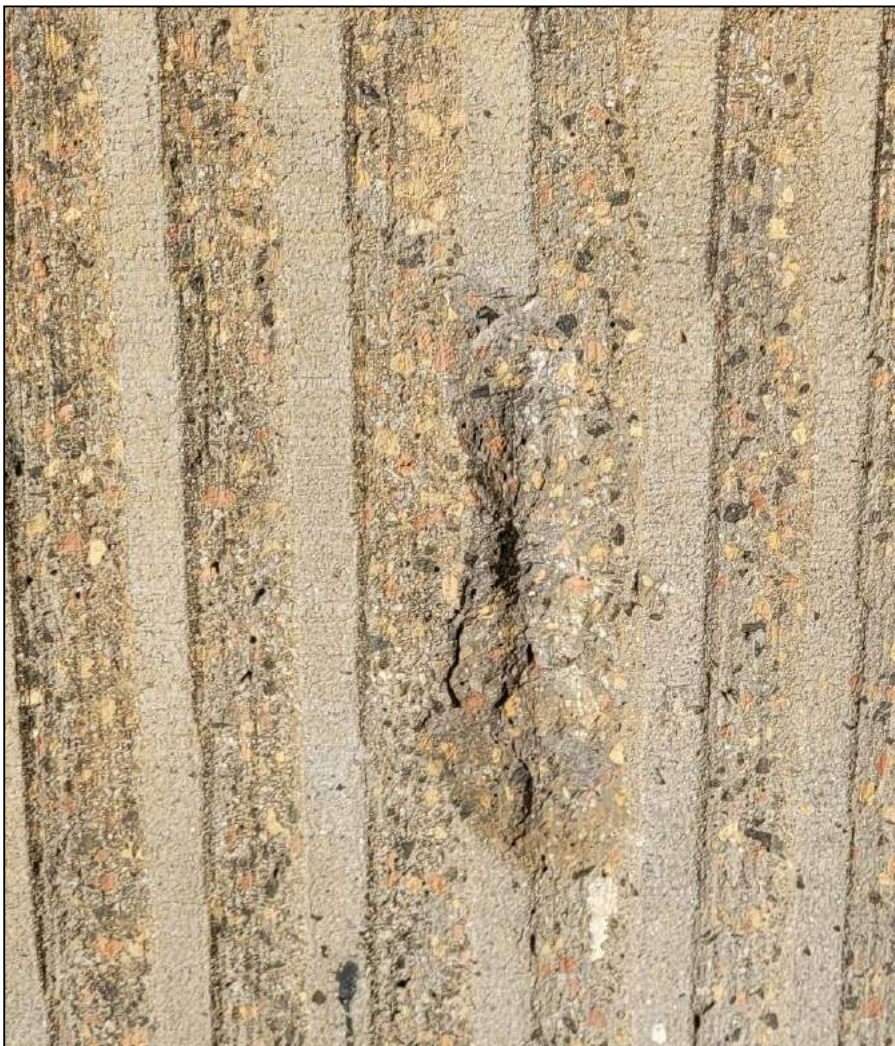
Fragment tynku kamieniarskiego cokołu. Widoczny sposób obróbki.
