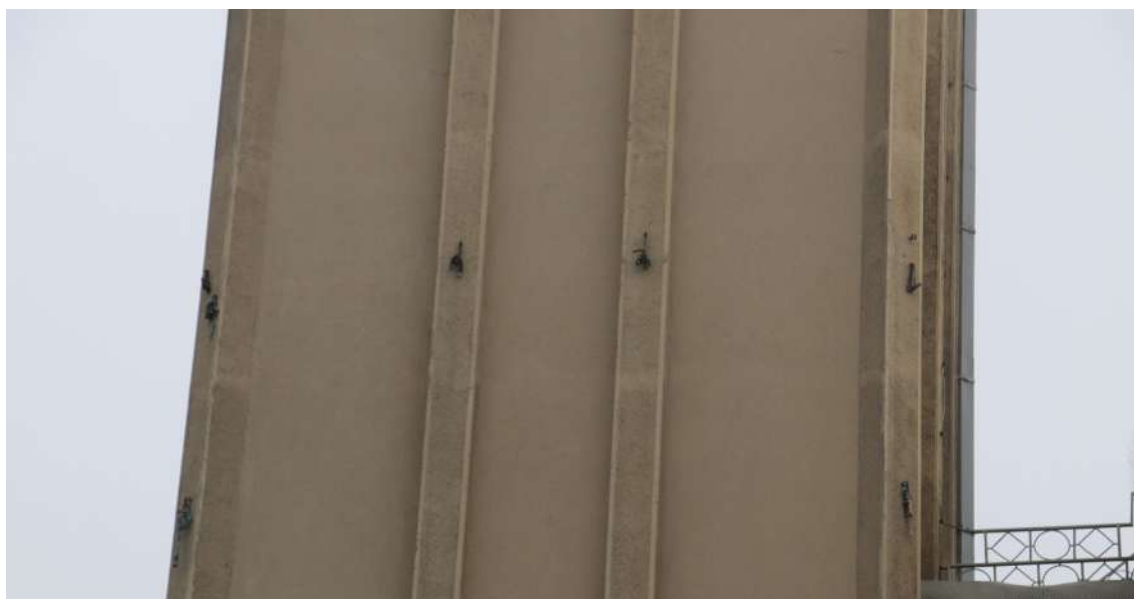
fot. 4: Elewacja południowa - widoczne uchwyty na czołach pilastrów.
