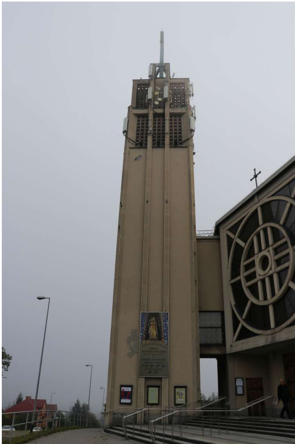
fot. 1: Elewacja południowa - widok ogólny.
