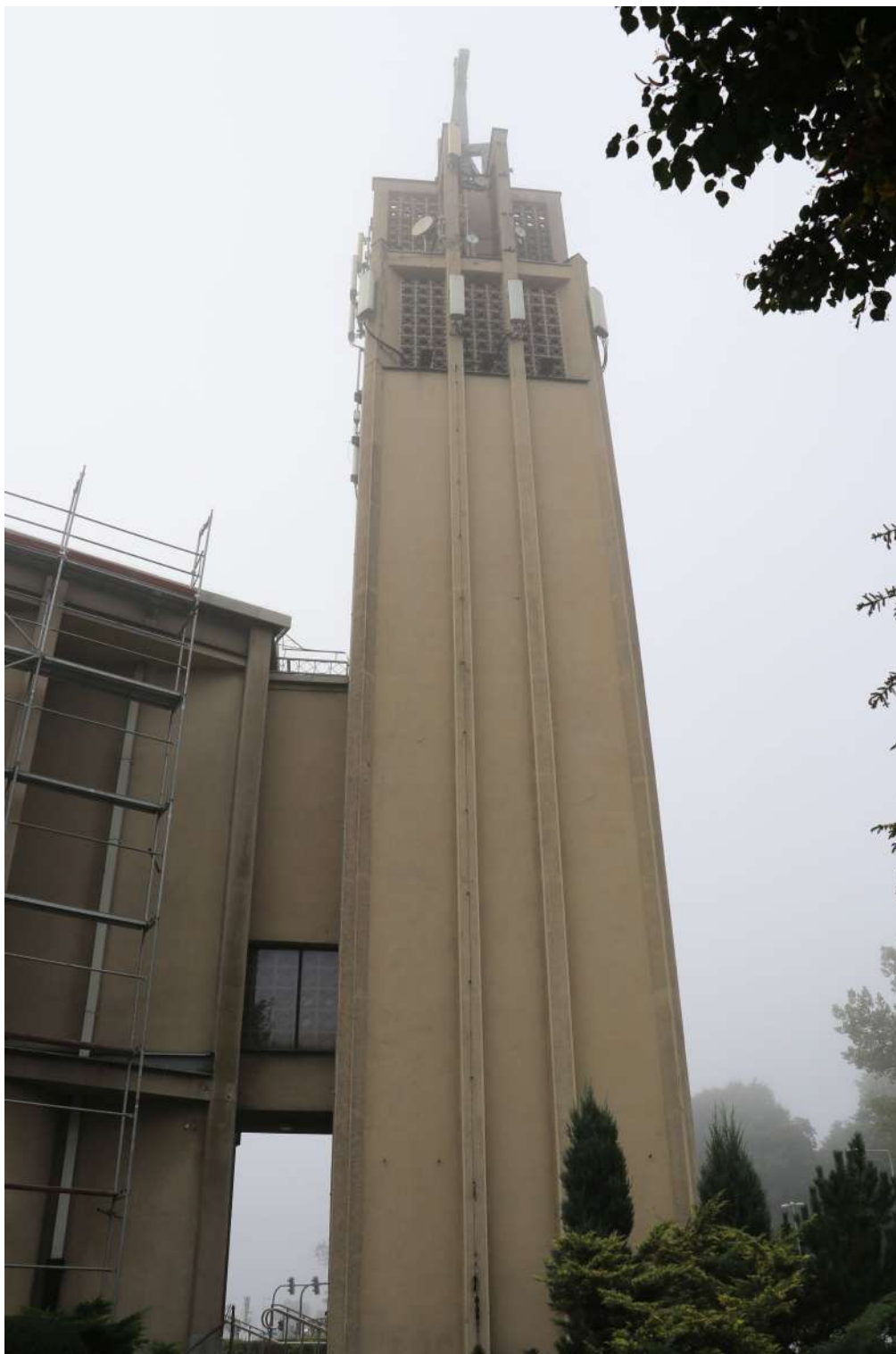
fot. 8: Elewacja północna - widok ogólny.
