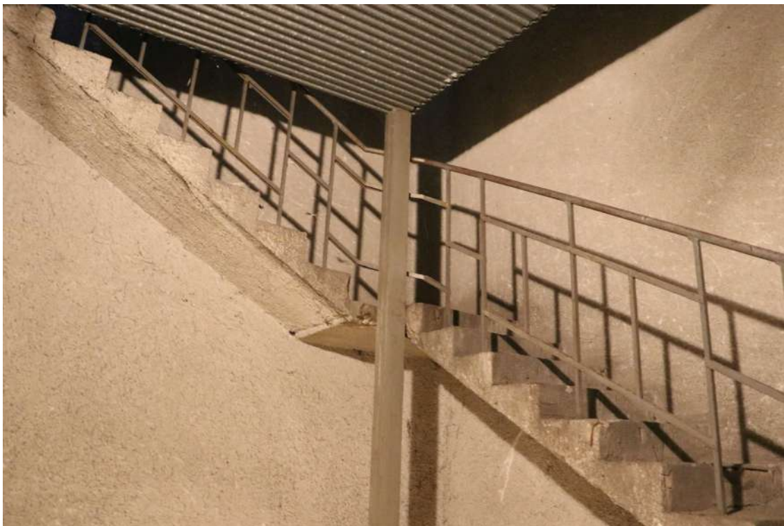
fot. 41: Wnętrze wieży - widoczny fragment klatki schodowej prowadzącej na szczyt wieży.
