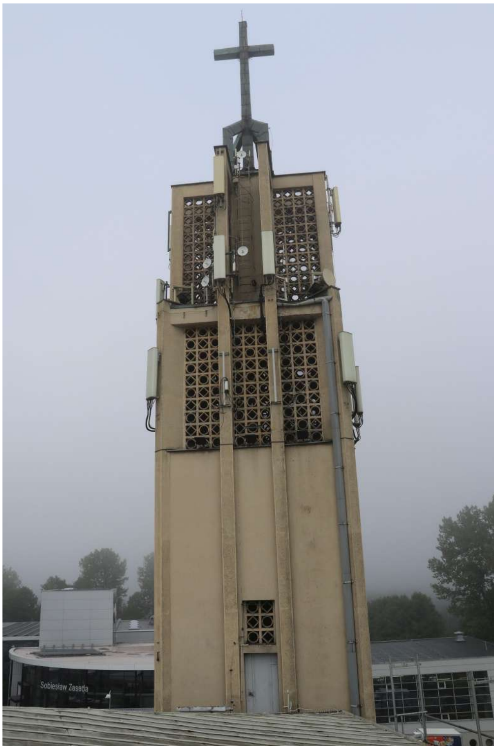
fot. 12: Elewacja wschodnia - widok ogólny.
