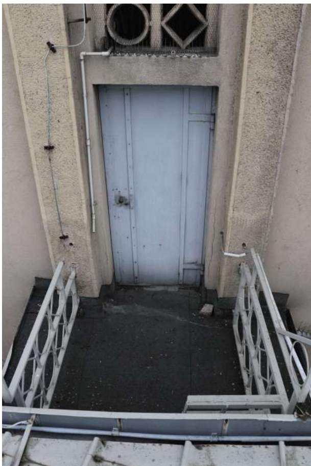
fot. 13: Elewacja wschodnia - metalowe drzwi wyjściowe.
