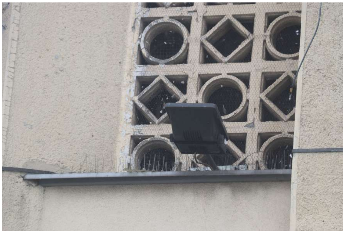
fot. 17: Elewacja wschodnia - widoczna lampa iluminacyjna.
