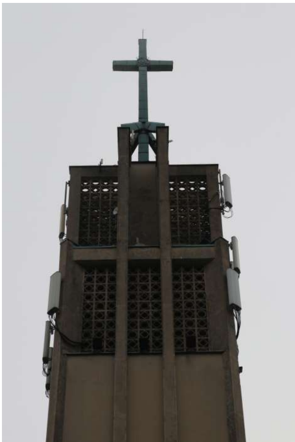
fot. 25: Elewacja zachodnia - widok ogólny ostatnich kondygnacji wieży.
