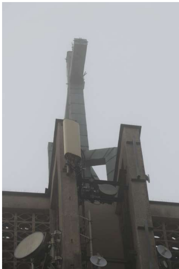
fot. 10: Elewacja północna - widoczne miejsca montażu urządzeń GSM oraz dotychczasowe wsporniki.
