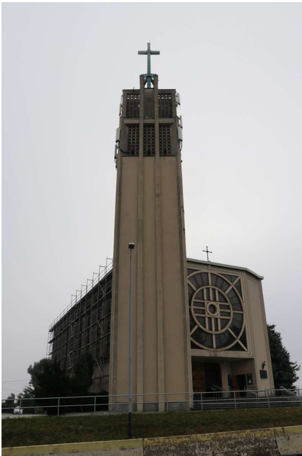
fot. 24: Elewacja zachodnia - widok ogólny.
