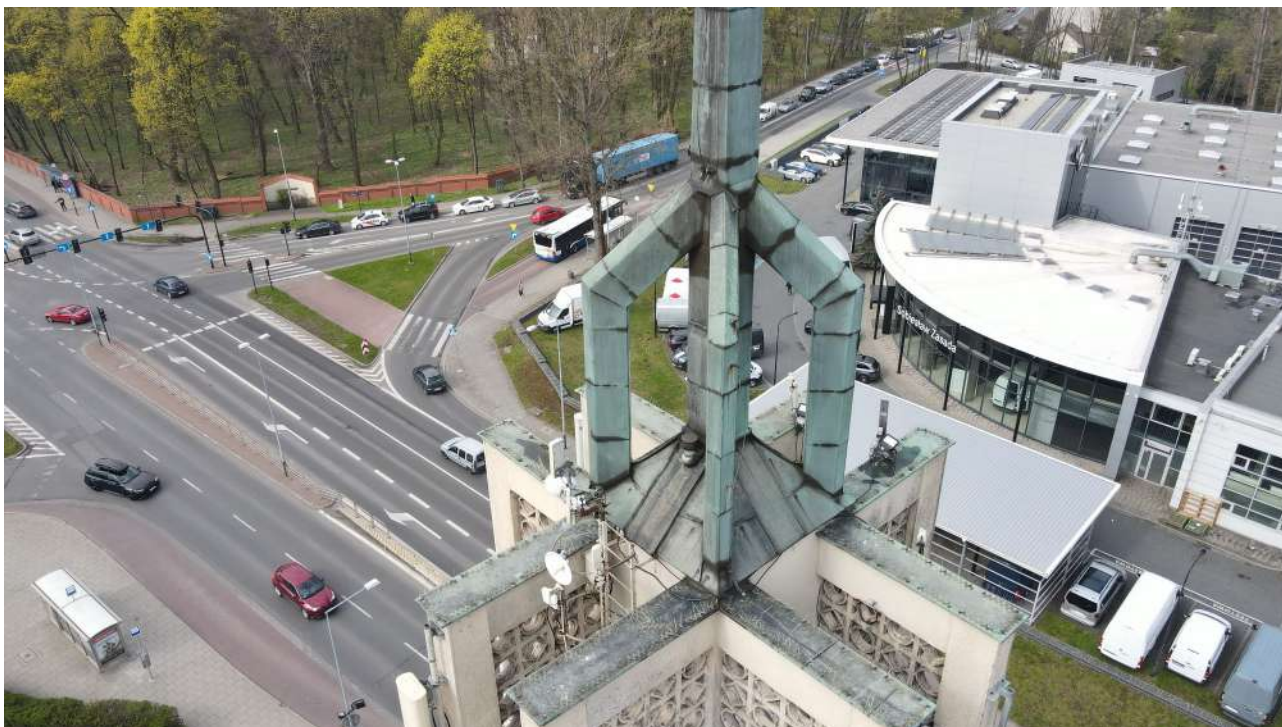
fot. 30: Widoczna podstawa krzyża wieży.
