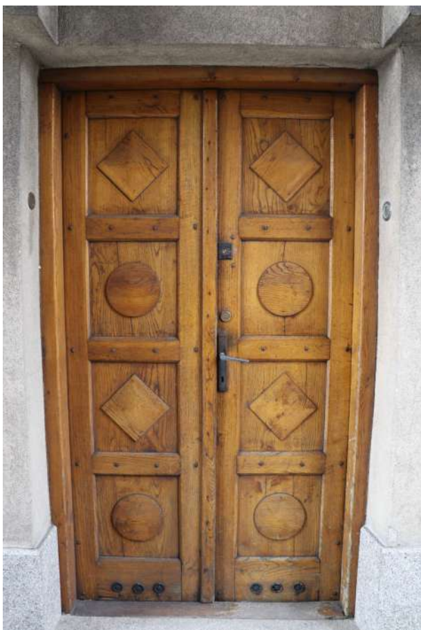
fot. 21: Elewacja wschodnia - drzwi wejściowe do wieży.
