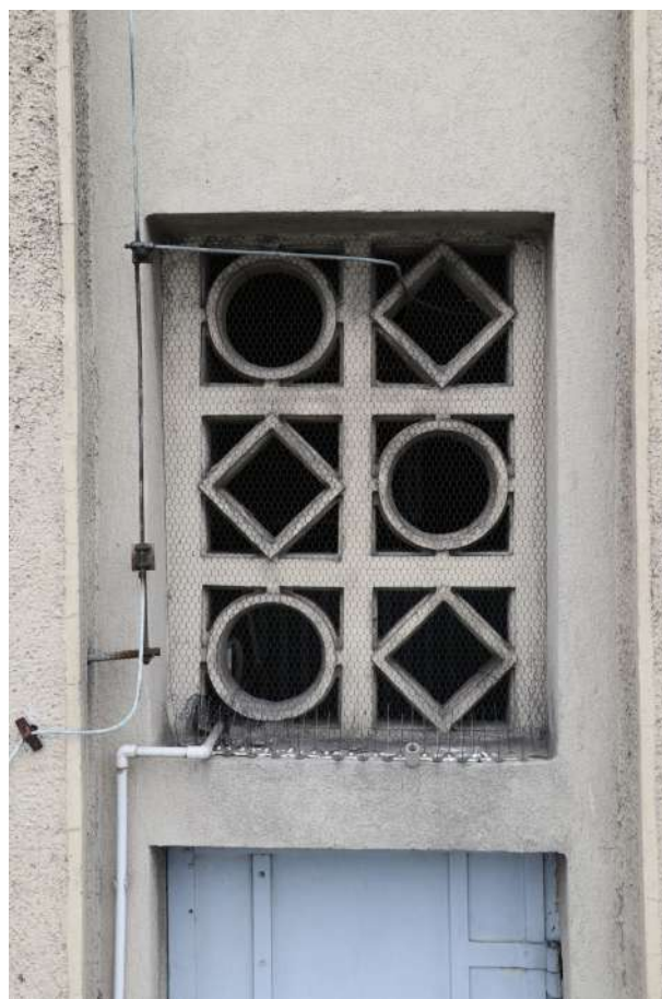
fot. 14: Elewacja wschodnia - widoczne okno z prefabrykowanymi kształtkami osłonięte siatką plecioną.
