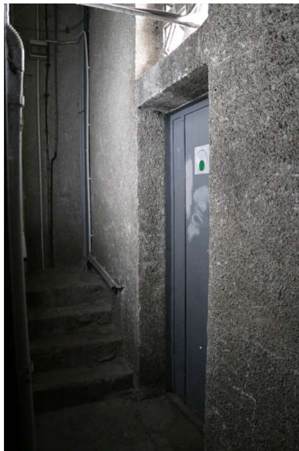
fot. 46: Wnętrze wieży - widoczne metalowe drzwi wyjściowe na dach przeznaczone do konserwacji.
