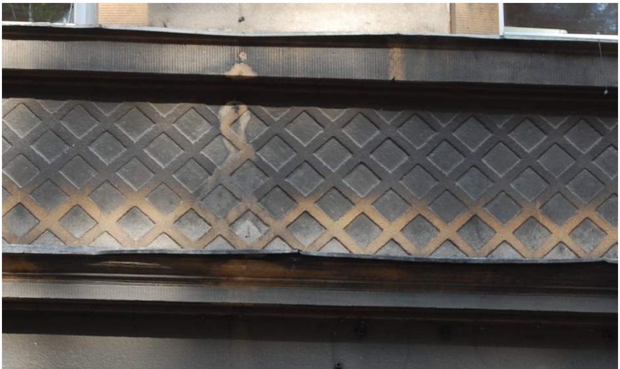
Fot 3. Fragment elewacji kamienicy przy ul. Podzamcze 20 w Krakowie
