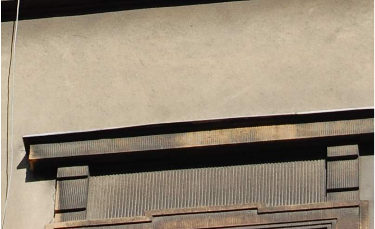
Fot 4. Fragment elewacji kamienicy przy ul. Podzamcze 20 w Krakowie
