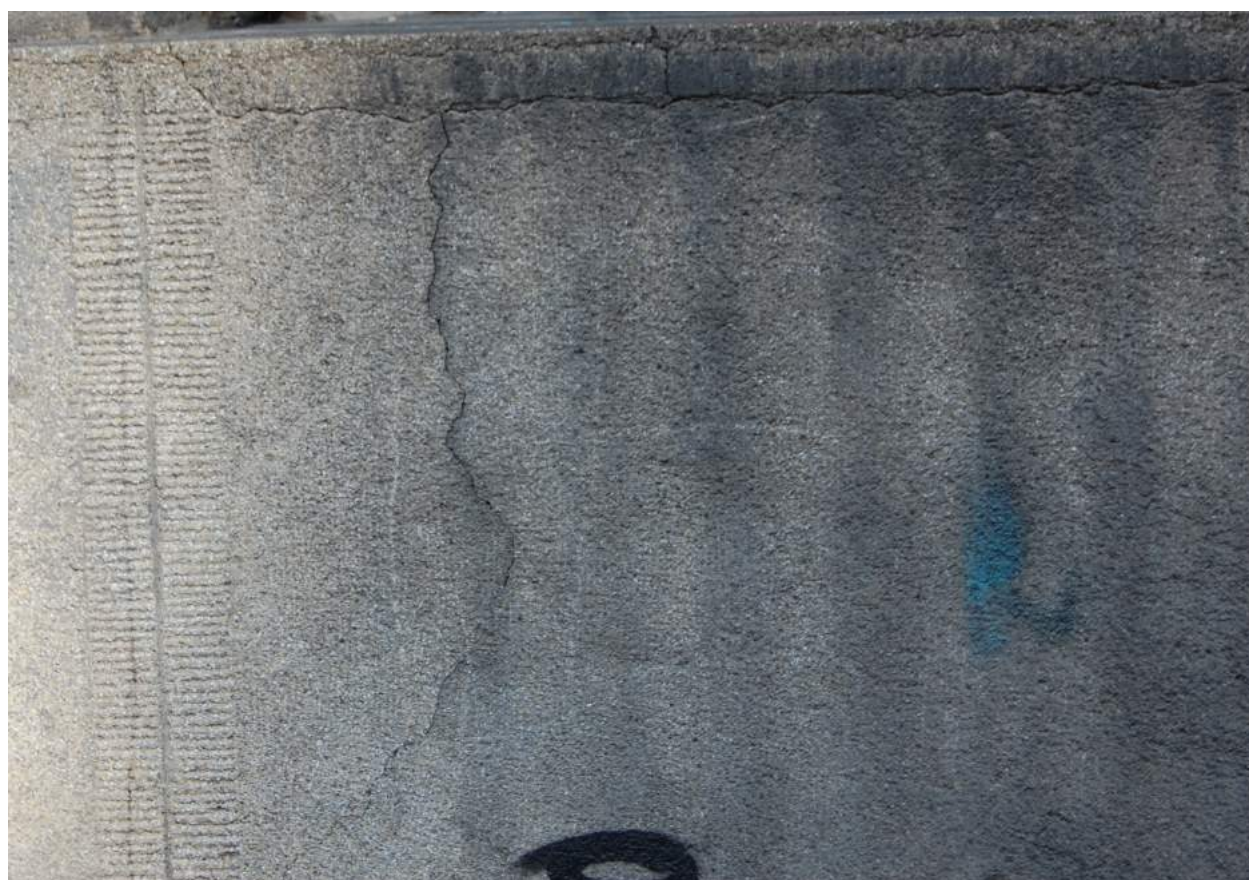
Fot 1. Fragment elewacji kamienicy przy ul. Podzamcze 20 w Krakowie
