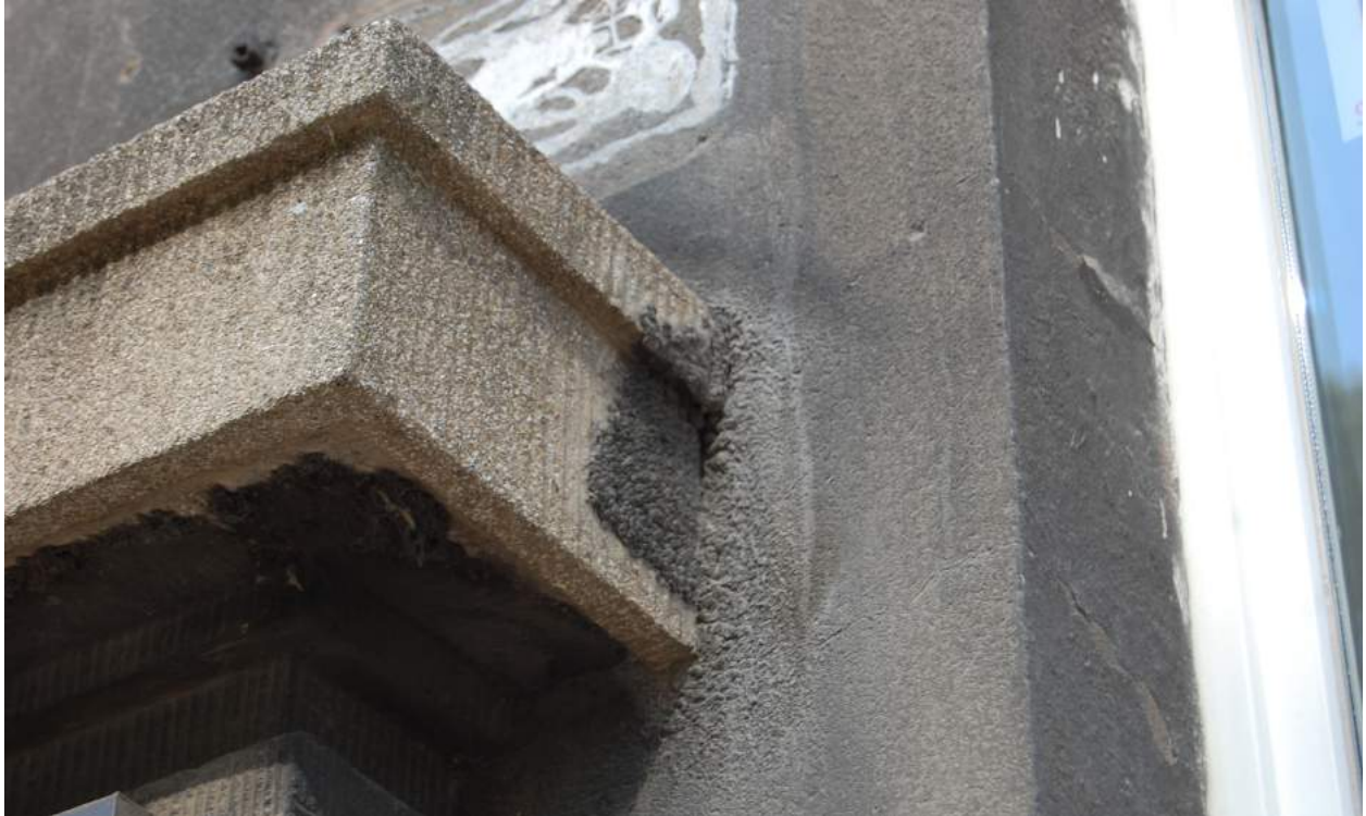
Fot 2. Fragment elewacji kamienicy przy ul. Podzamcze 20 w Krakowie
