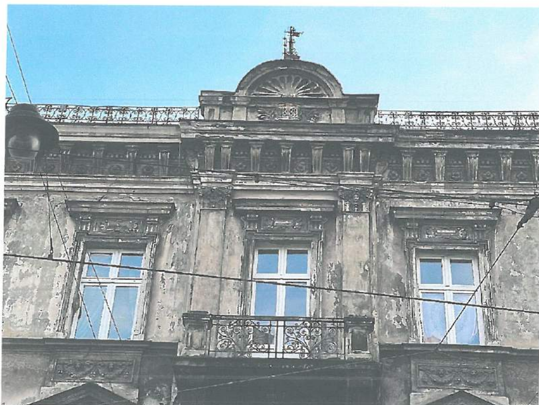
Fot.4. Kraków, ul. Starowińska 23 – elewacja frontowa – stan zachowania. Fot. M. Ratajczyk 28.04.2022
