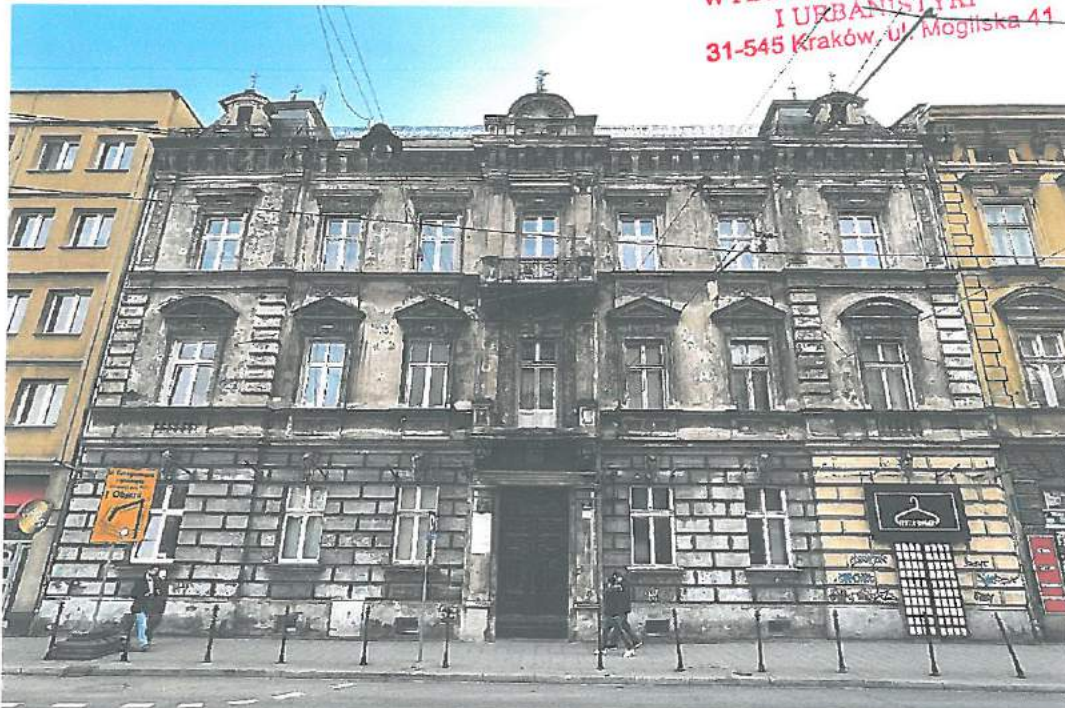
Fot.3. Kraków, ul. Starowińska 23 – elewacja frontowa – stan zachowania. Fot. M. Ratajczyk 28.04.2022
