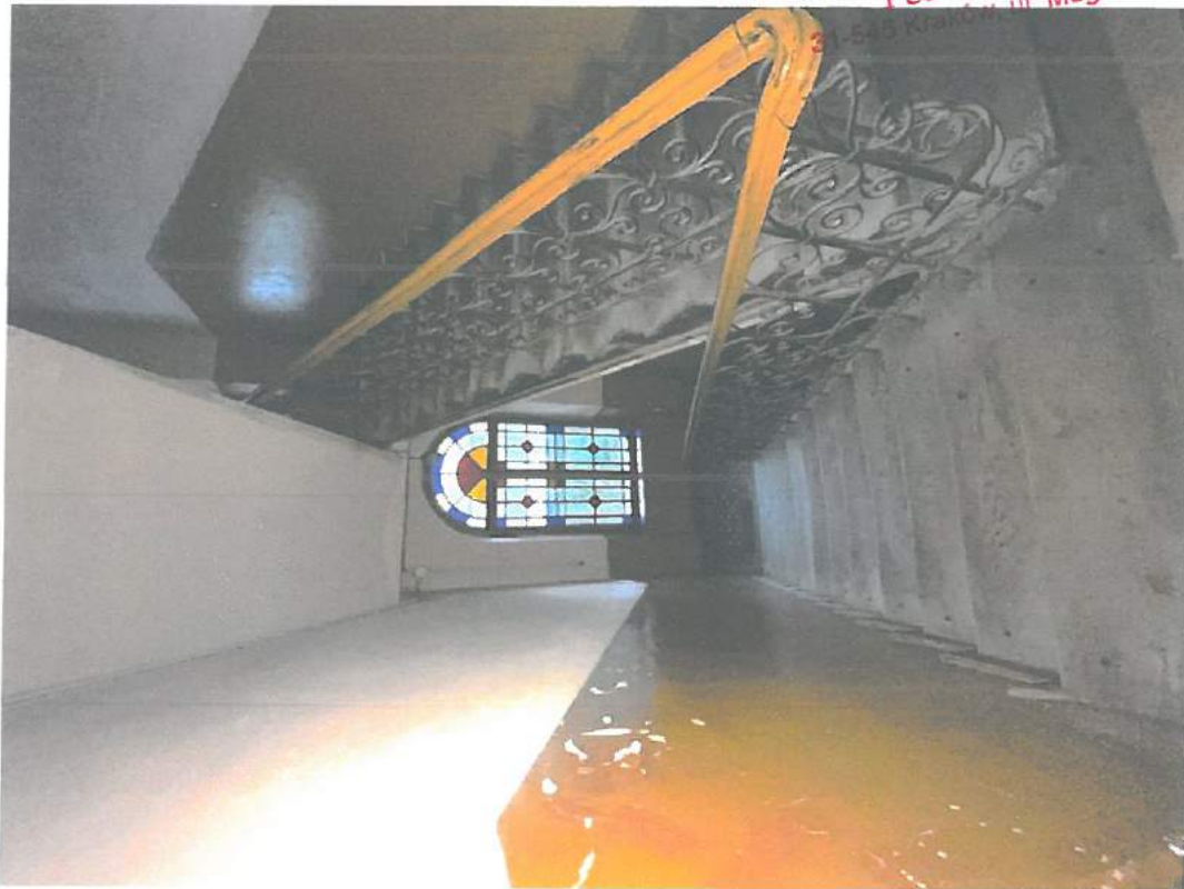
Fot.45. Kraków, ul. Starowiślna 23 – klatka schodowa, bieg schodów prowadzący na II p. – stan zachowania. Fot. M. Ratajczyk 28.04.2022
