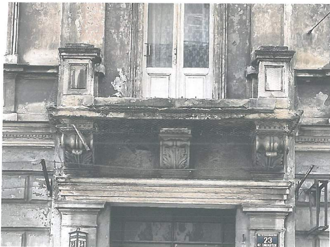
Fot.12. Kraków, ul. Starowiślna 23 – elewacja frontowa – stan zachowania. Widoczny brak balustrady balkonu na pierwszym piętrze. Fot. M. Ratajczyk 28.04.2022
