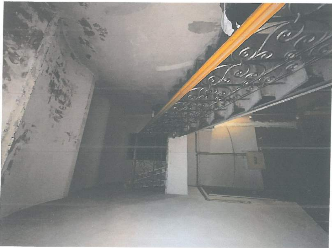
Fot.50. Kraków, ul. Starowiślna 23 – klatka schodowa, bieg schodów prowadzący na strych – stan zachowania. Fot. M. Ratajczyk 28.04.2022
