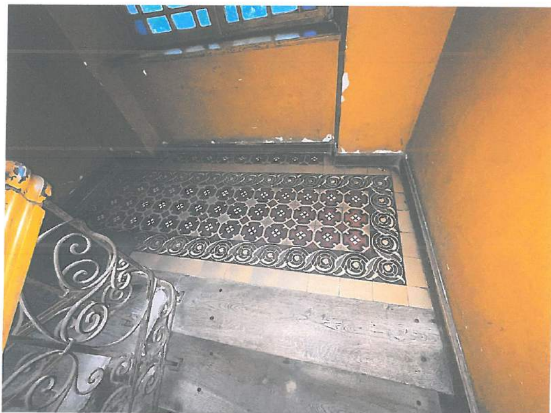
Fot.42. Kraków, ul. Starowiślna 23 – klatka schodowa, posadzka dywanowa na spoczniku półpiętra I – II p. – stan zachowania. Fot. M. Ratajczyk 28.04.2022
