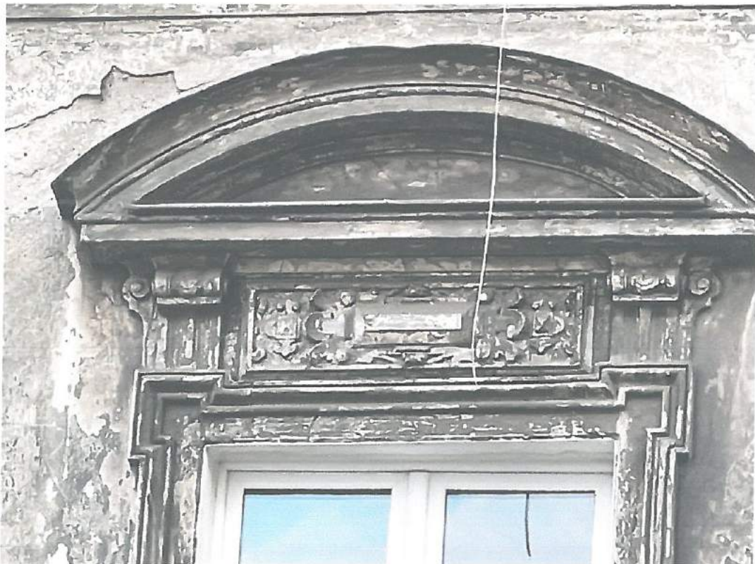
Fot.16. Kraków, ul. Starowiślna 23 – elewacja frontowa – stan zachowania. Widoczne zabrudzenia złuszczenia nadokiennika. Fot. M. Ratajczyk 28.04.2022
