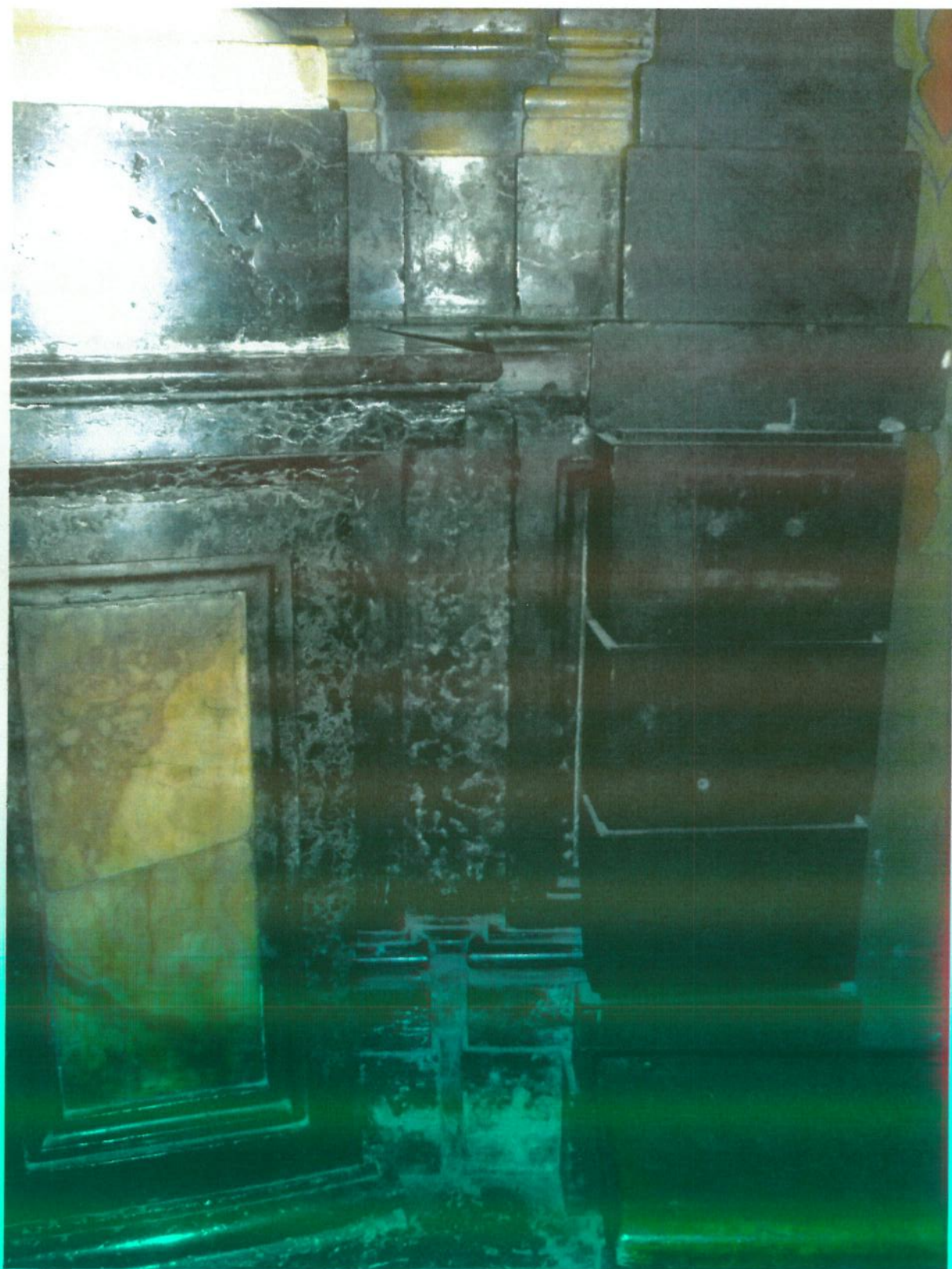
Ołtarz Matki Boskiej Nieustającej Pomocy. Nawa, ściana południowa, fragment cokołówkolumny i pilastra zach., widoczne zabrudzenia na powierzchni kamienia, pęknięcia w obrębie płyciny z marmuru paczółtowskiego, zmatowienia i przebarwienia pasty na powierzchni marmuru, liczne wżery na powierzchni, oraz uszkodzenia krawędzi. U podstawy cokołów pilastrów widoczne białe wykwity wykrystalizowanej soli i gipsu.
