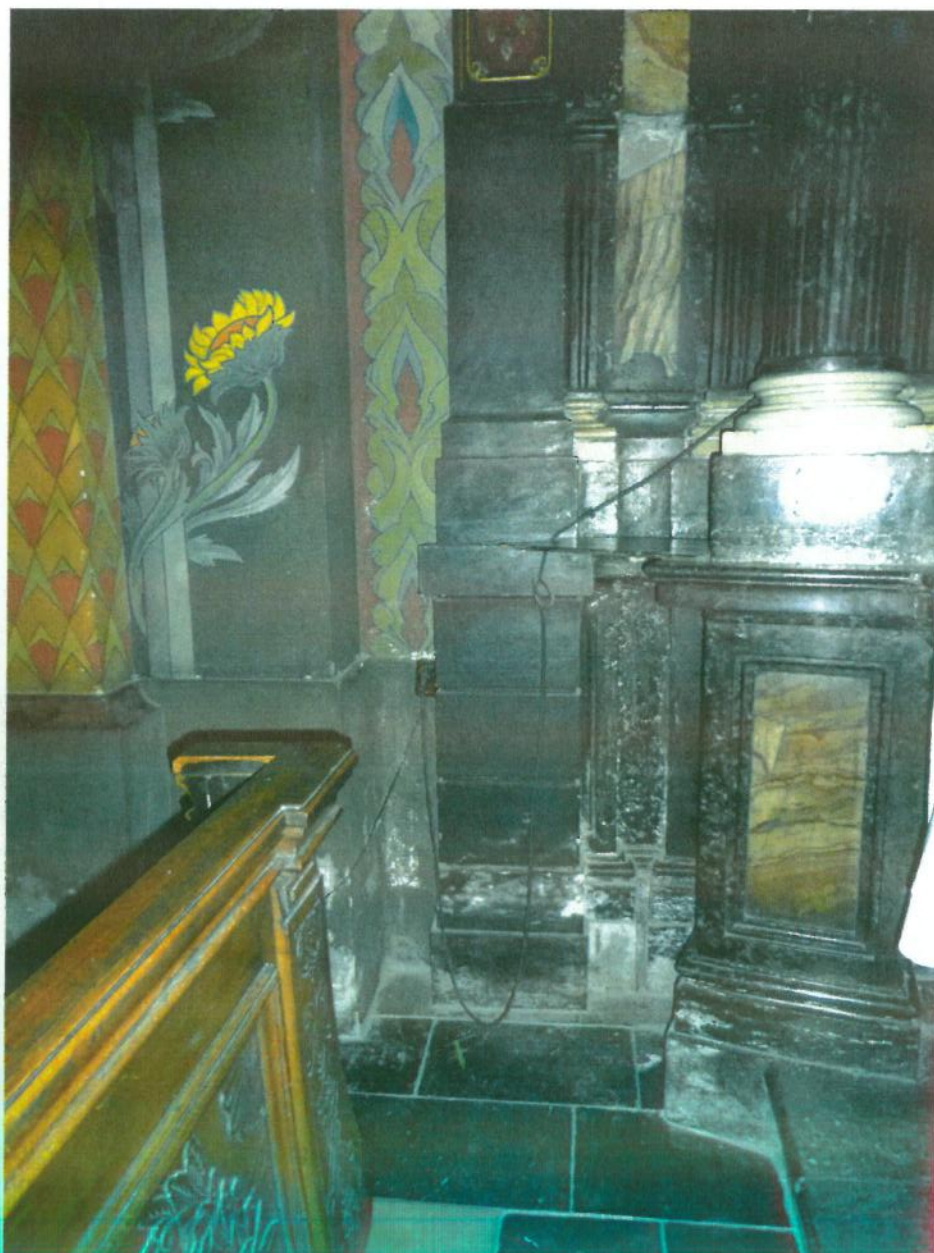
Ołtarz Matki Boskiej Nieustającej Pomocy. Nawa, ściana południowa, fragment kolumny i pilastra wsch., widoczne zabrudzenia na powierzchni kamienia, pęknięcia w obrębie płyciny z marmuru paczółtowieckiego z d ubytkiem, zmatowienia i przebarwienia pasty na powierzchni marmuru, liczne wżery na powierzchni, oraz uszkodzenia krawędzi. Widoczne wysolenia u podstawy cokołów pilastrów.
