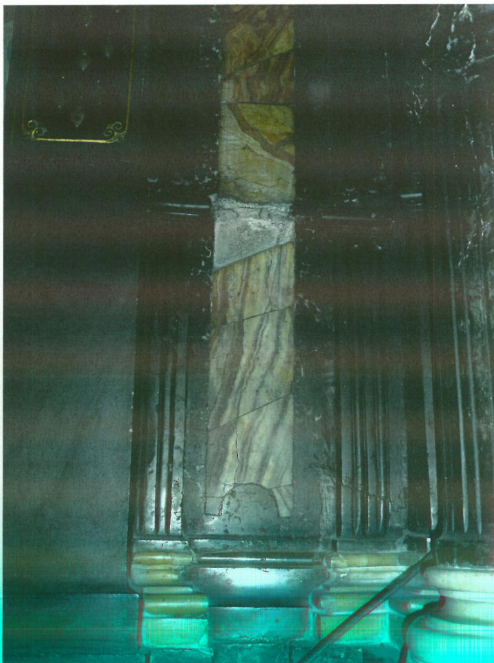
Ołtarz Matki Boskiej Nieustającej Pomocy. Nawa, ściana południowa, fragment kolumny i pilastra wsch., widoczne zabrudzenia na powierzchni kamienia, pęknięcia w obrębie płyciny z marmuru paczółtowskiego z d ubytkiem, zmatowienia i przebarwienia pasty na powierzchni marmuru, liczne wżery na powierzchni, oraz uszkodzenia krawędzi. Widoczne kity gipsowe na łączeniu pilastra wewnętrznego i płyciny o nierównej powierzchni zamalowanej czarną farbą.
