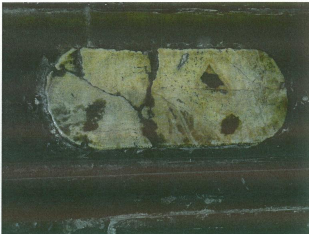
Ołtarz św. Maksymiliana Kolbe, nawa, ściana południowa, detal. Widoczne zabrudzenia powierzchni, ubytki i wżery na powierzchni. Spękania i uzupełnienia cementowe na powierzchni wstawki z marmuru paczółtowskiego.
