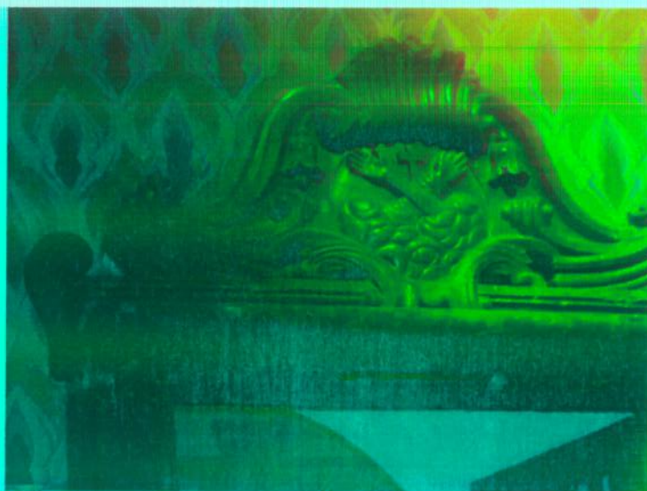
Portal prowadzący do kaplicy Meki Pańskiej ,fragment, widoczne uszkodzenia i ubytki formy rzeźbiarskiej w partii zwieńczenia.
