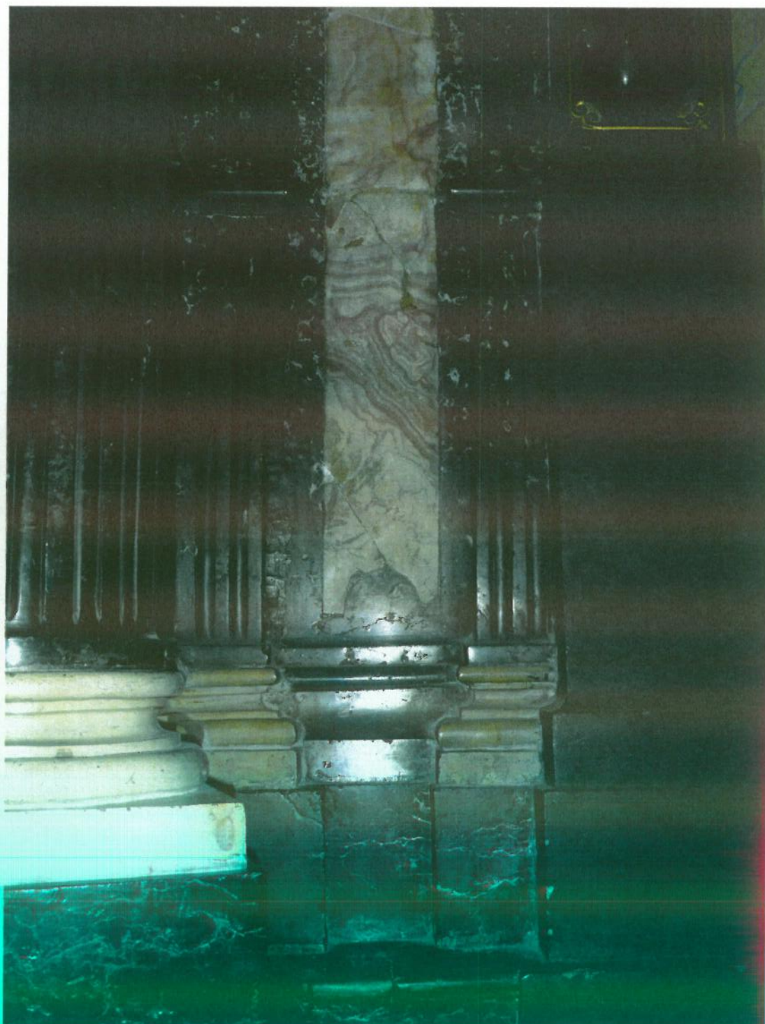
Ołtarz Matki Boskiej Nieustającej Pomocy. Nawa, ściana południowa, fragment nastawy, widoczne zabrudzenia na powierzchni kamienia, pęknięcia w obrębie płyciny z marmuru paczółtowskiego, zmatowienia i przebarwienia pasty na powierzchni marmuru, liczne wżery na powierzchni, gipsowe kity pomalowane na czarno, oraz uszkodzenia krawędzi
