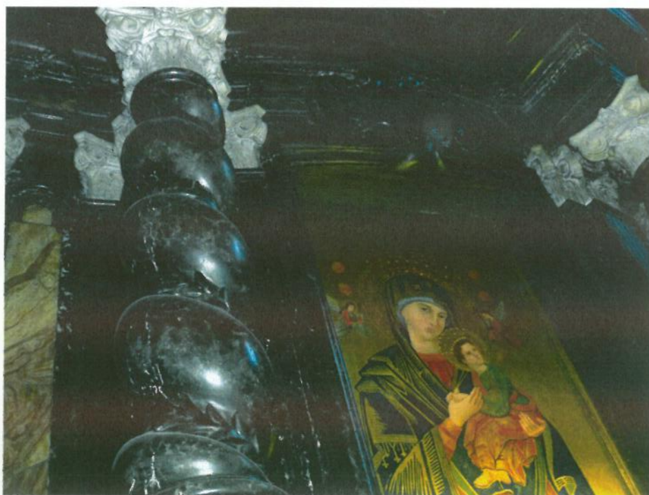
Ołtarz Matki Boskiej Nieustającej Pomocy. Nawa, ściana południowa, fragment nastawy, widoczne zabrudzenia na powierzchni kamienia, pęknięcia
