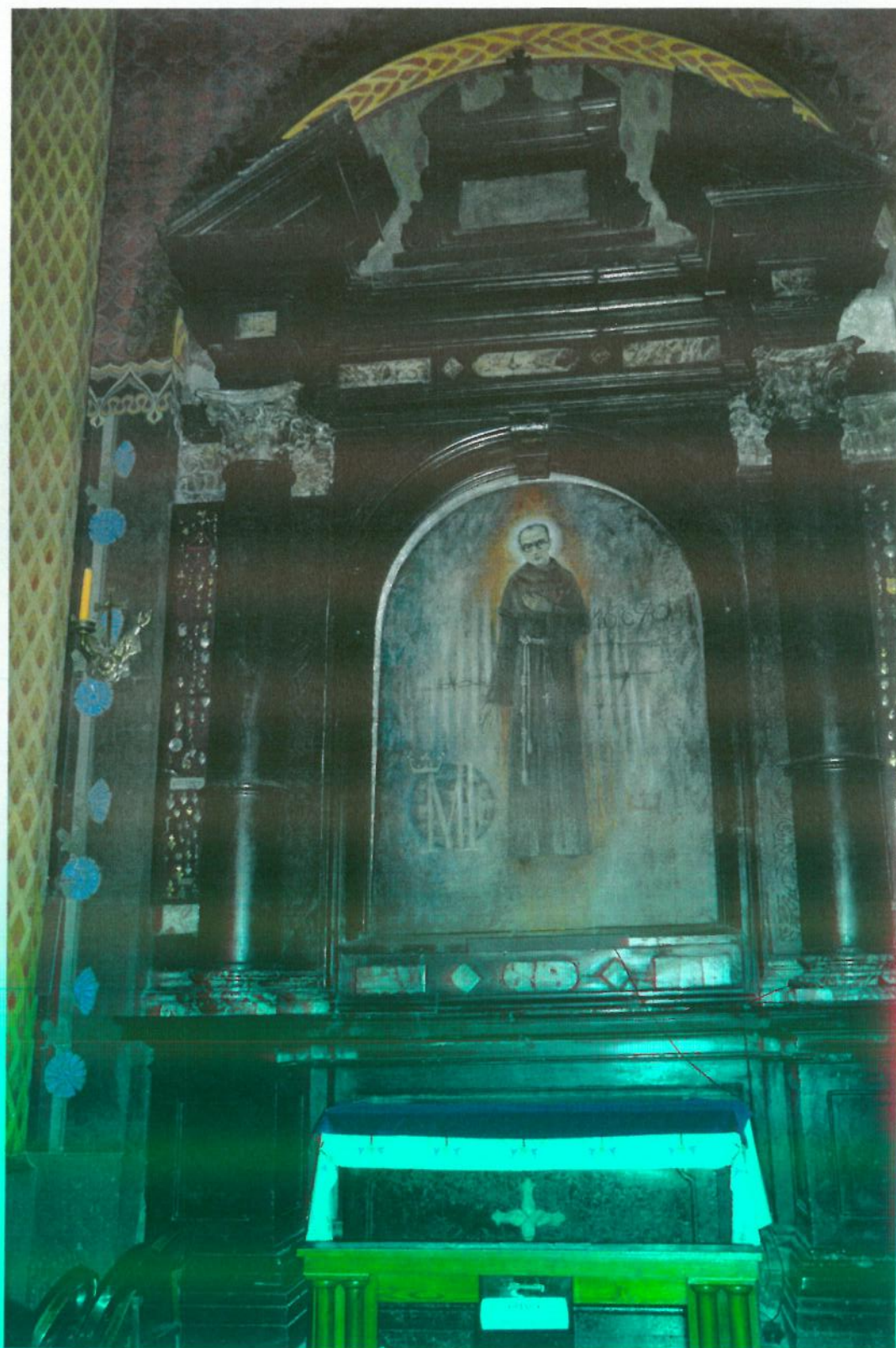
Ołtarz św. Maksymiliana Kolbe, nawa, ściana południowa. Widoczne zabrudzenia powierzchni i liczne ubytki w partiach profili.
