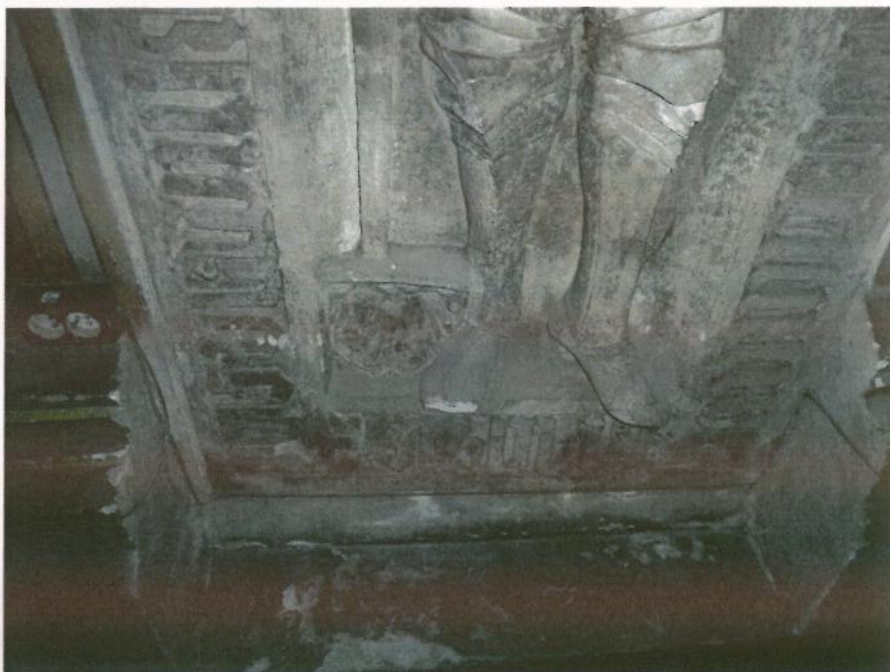
Kraków. Kościół p.w. św. Franciszka z Asyżu. Prezbiterium strona północna A. Płyta nagrobna nieznanego księcia Władysława /zm.1270/. Dolny fragment. Widoczne zabrudzenia oraz ubytki mechaniczne.
