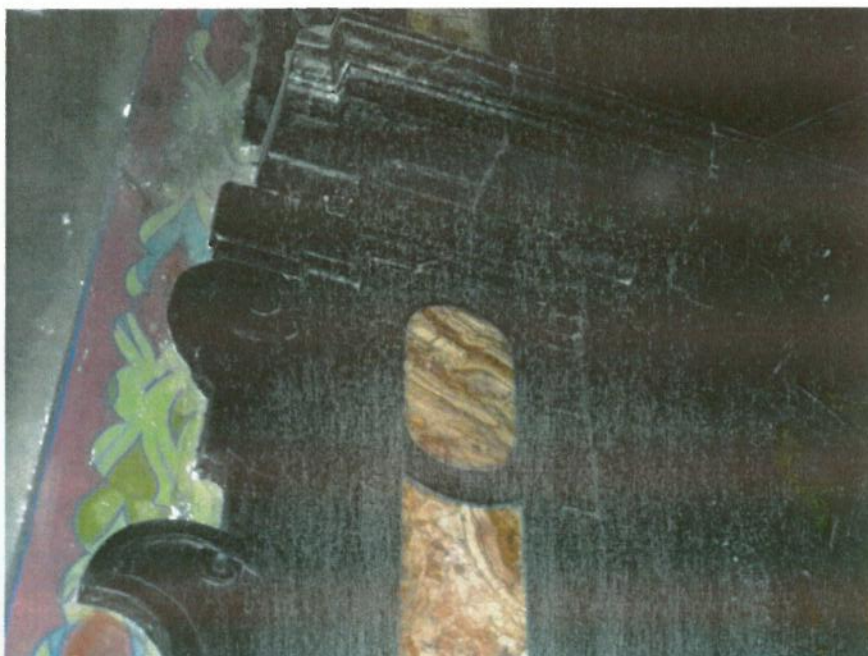
Portal do kaplicy Matki Bożej Bolesnej, fragment, widoczne spoiny wypełnione gipsem zamalowane na czarny kolor.
