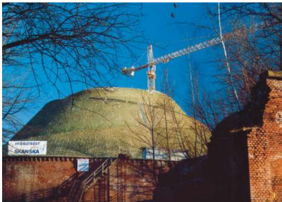
9. Kopiec Kościuszki przed zakończeniu remontu
