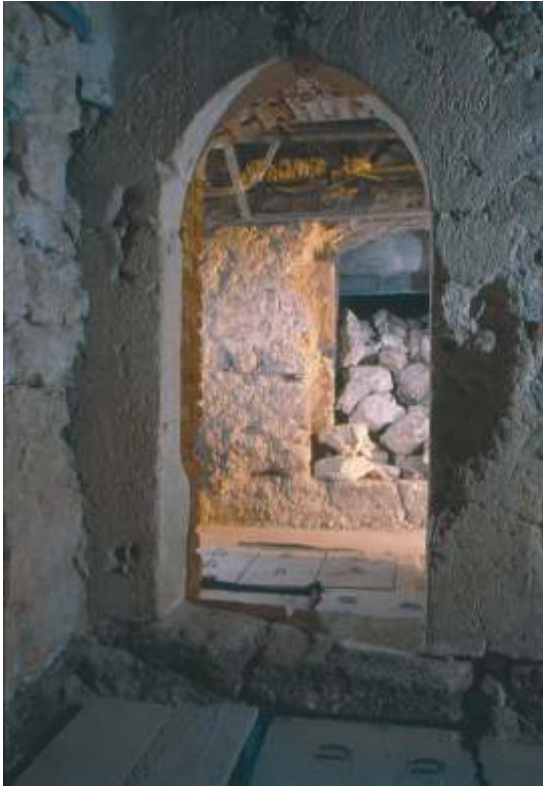
7. Prace remontowo-konserwatorskie w piwnicach Collegium Maius UJ
