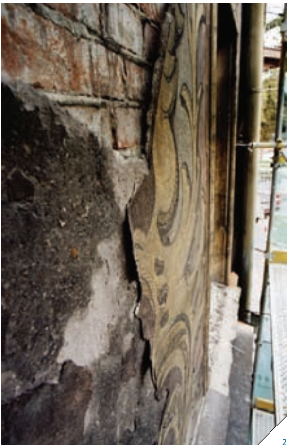
1-2. Fragment dekoracji malarskiej. Stan zachowania przed konserwacją
