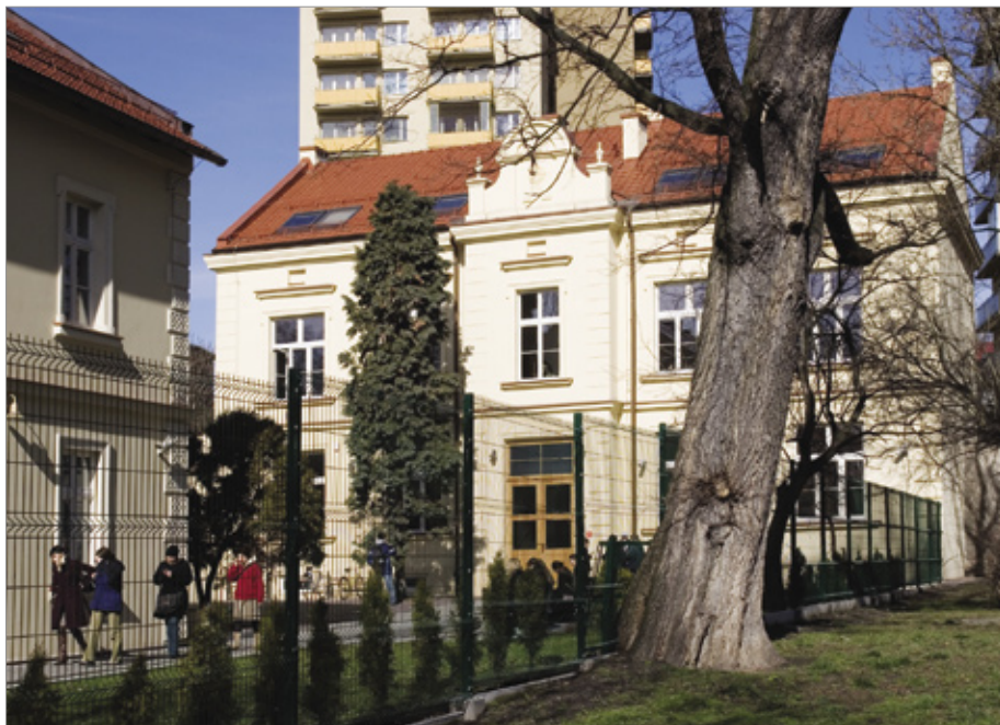
14. Odnowiona elewacja obiektu Akademii Pedagogicznej przy ul. Mazowieckiej 43.
