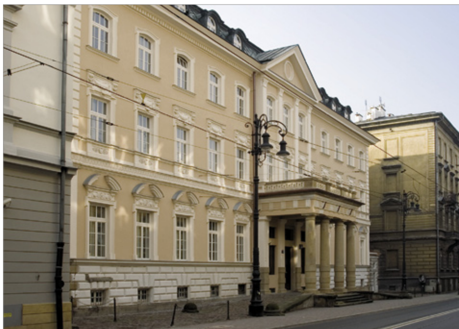
11. Odnowiona elewacja dawnego pałacu Potulickich, Wyższe Seminarium Duchowne, ul. Pilsudskiego 4.
