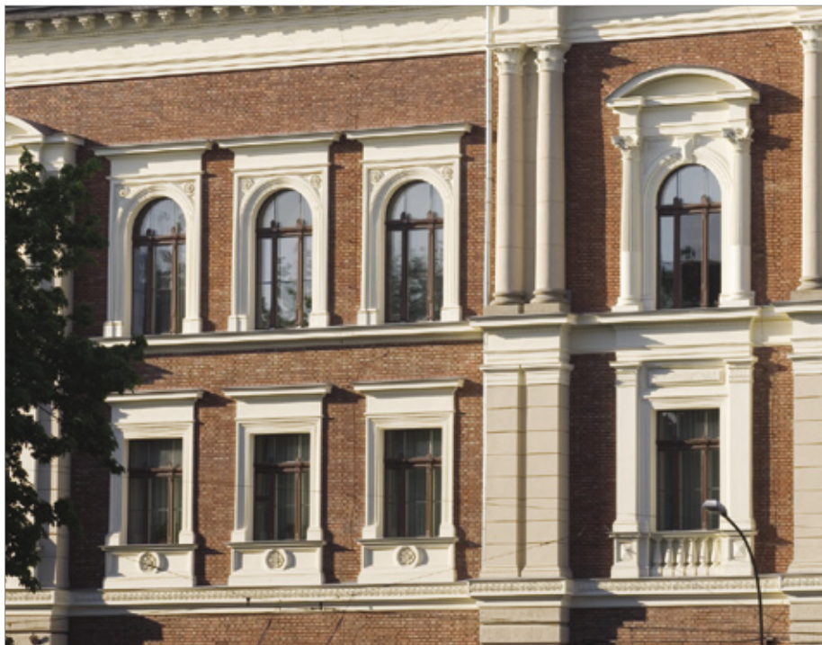
17. Odnowiona elewacja siedziby Akademii Sztuk Pięknych w Krakowie od strony ul. Basztowej.
