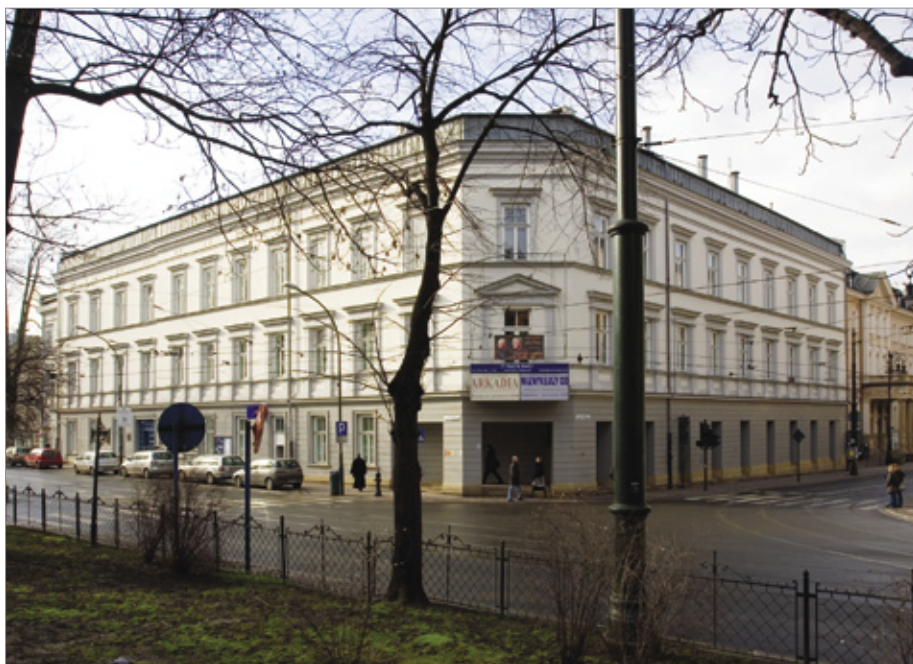
15. Fasada Państwowej Wyższej Szkoły Teatralnej przy ul. Straszewskiego 22 po konserwacji.
