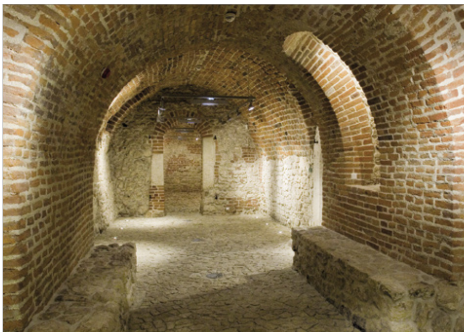
18. Piwnice pałacu Krzysztofy po remoncie konserwatorskim.
