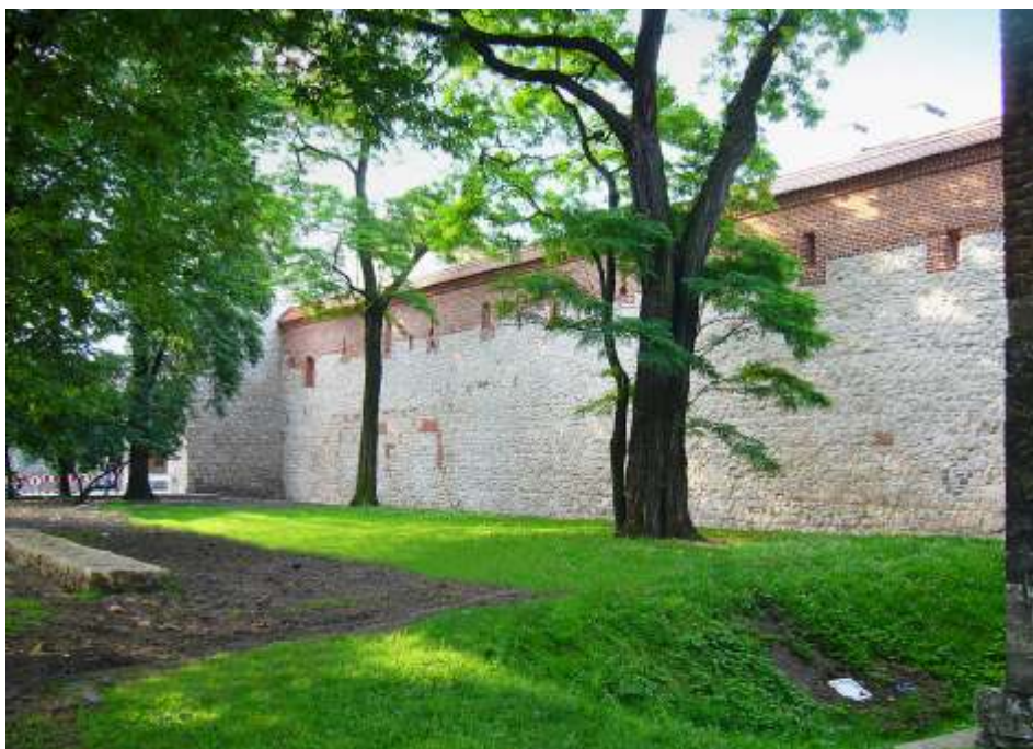
16. Mury obronne po konserwacji, odcinek od Bramy Floriańskiej do Arsenalu (fot. Michał Grychowski)
