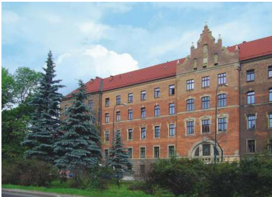
15. Częściowo odnowiona elewacja frontowa Collegium Godlewskiego przy al. Mickiewicza 21, siedziba Akademii Rolniczej (fot. Maciej Grychowski)
