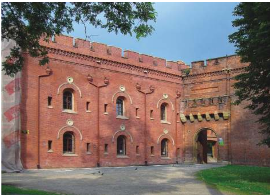
13. Kaponiera przy Kopcu Kościuszki, widok po częściowej konserwacji (fot. Michał Grychowski)
