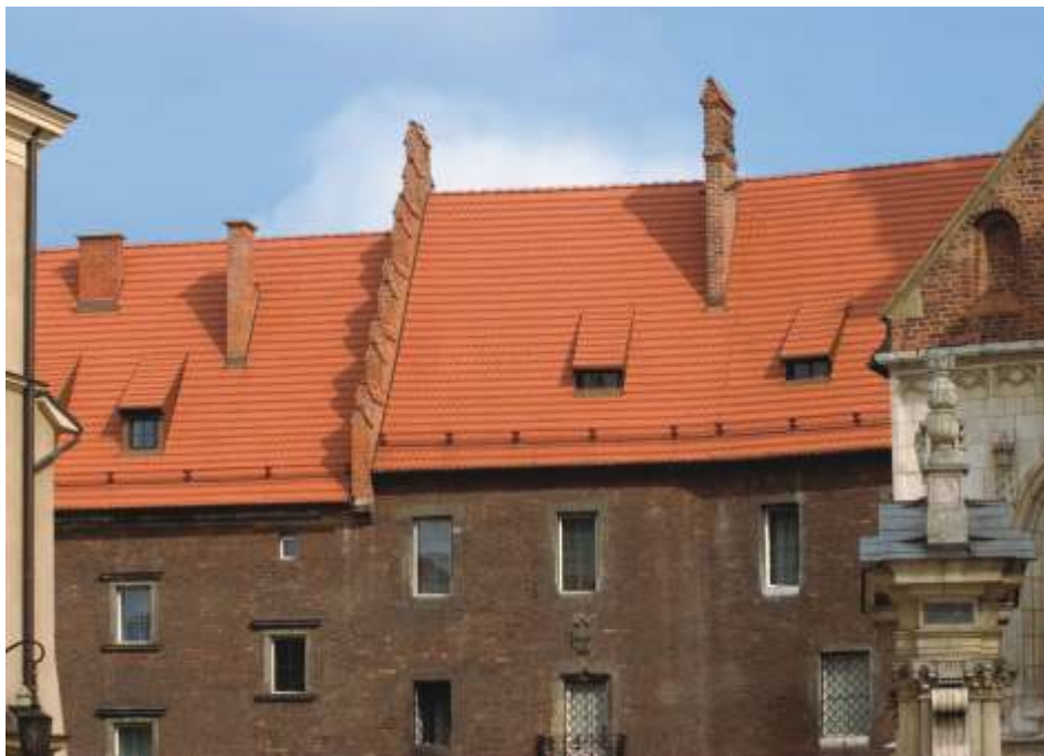
7. Frontowa elewacja bud. nr 2 na Wawelu mieszczącego Muzeum Katedralne. Widoczne połacie dachu po wymianie pokrycia (fot. Michał Grychowski)
