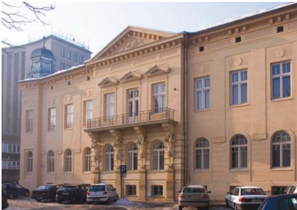
9. Odnowiona elewacja pałacu Tyszkiewiczów
