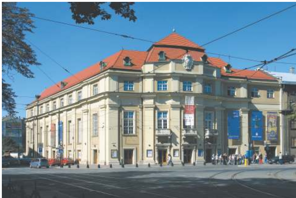
4. Elewacja Filharmonii Krakowskiej po renowacji
