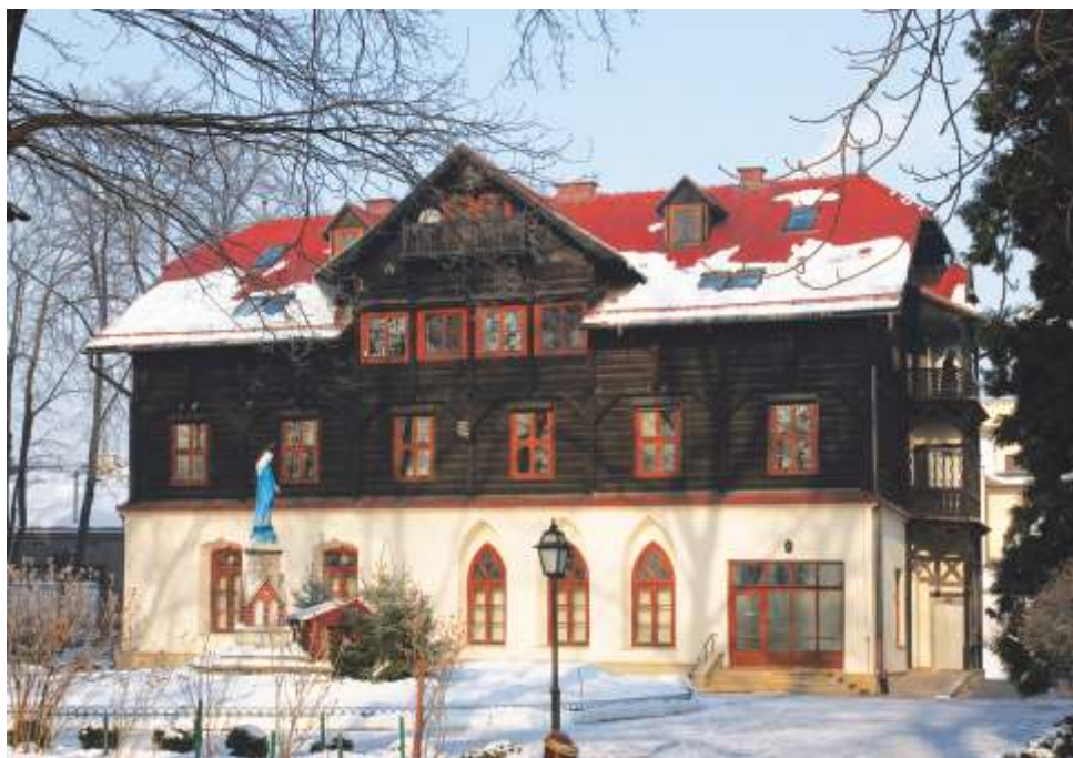
5. Jeden z odnowionych budynków projektu Jana Sas Zubrzyckiego w zespole klasztornym ss. Albertynek przy ul. Woronicza 10
