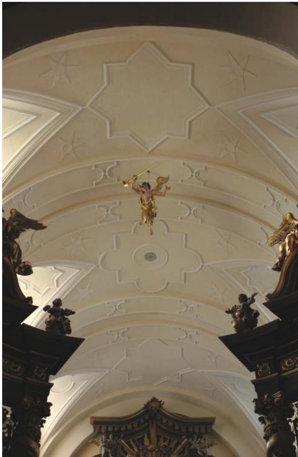
7. Odnowione sklepienie prezbiterium kościoła oo. Bernardynów w części chóru zakonnego
