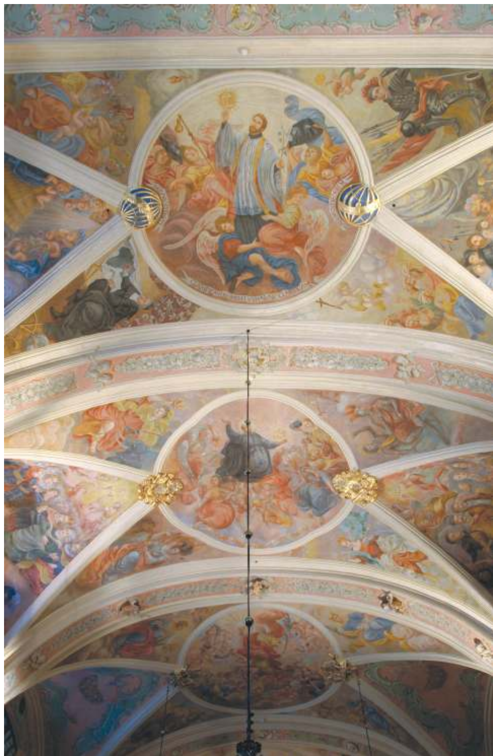
14. Fragment sklepienia nawy głównej kościoła św. Barbary po konserwacji
