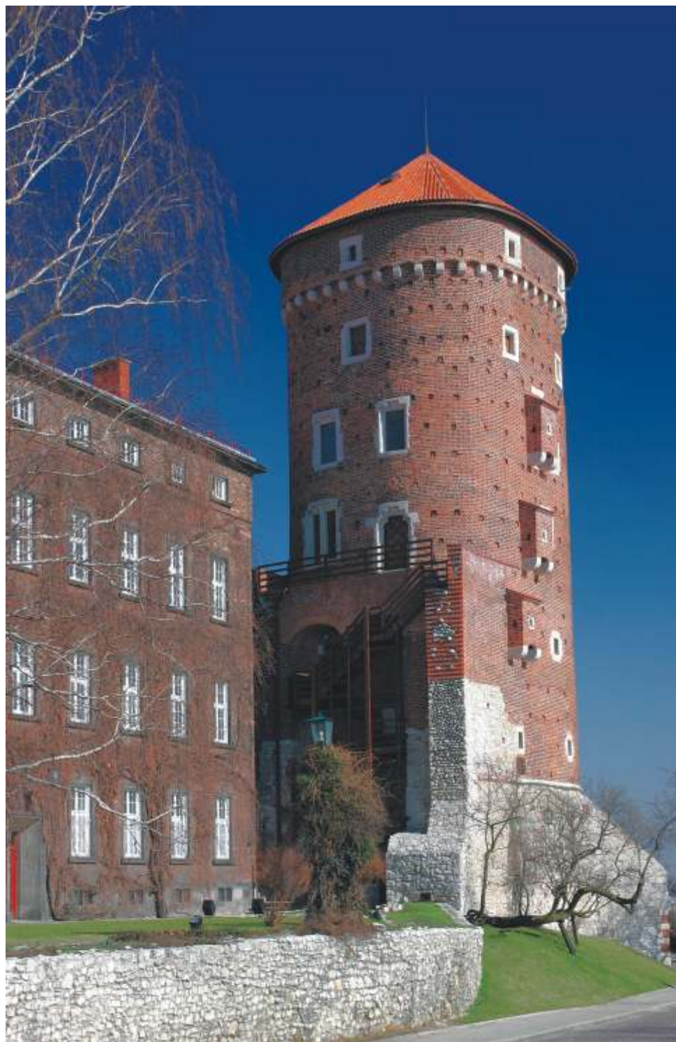
21. Baszta Sandomierska na Wawelu po generalnym remoncie. Fot. M. Grychowski
