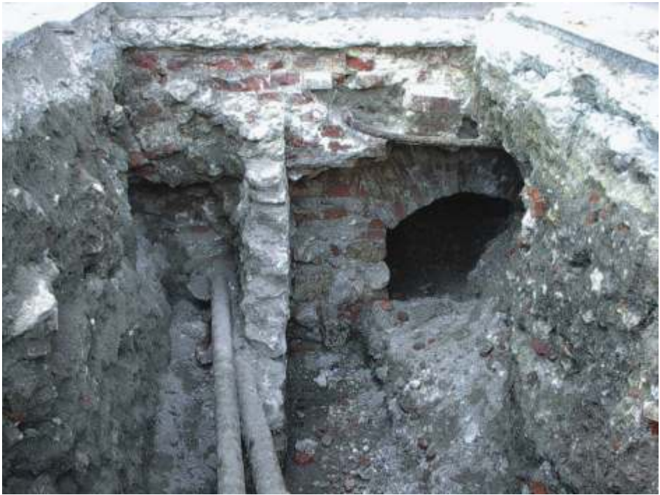
↑1. Wykop w rejonie północno-wschodniego narożnika Sukienic wykonany w 2003 roku z widocznym murem fundamentowym arkad i reliktem wtórnej ściany działowej kramów (fot. autor)
