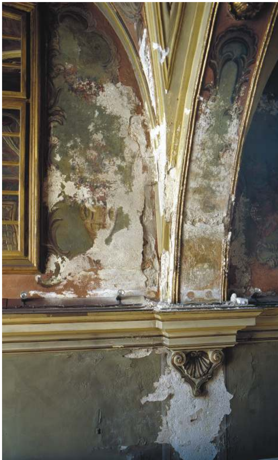
5. Kościół św. Barbary, ściana północna w kościele przed konserwacją (fot. M. Grychowski)
