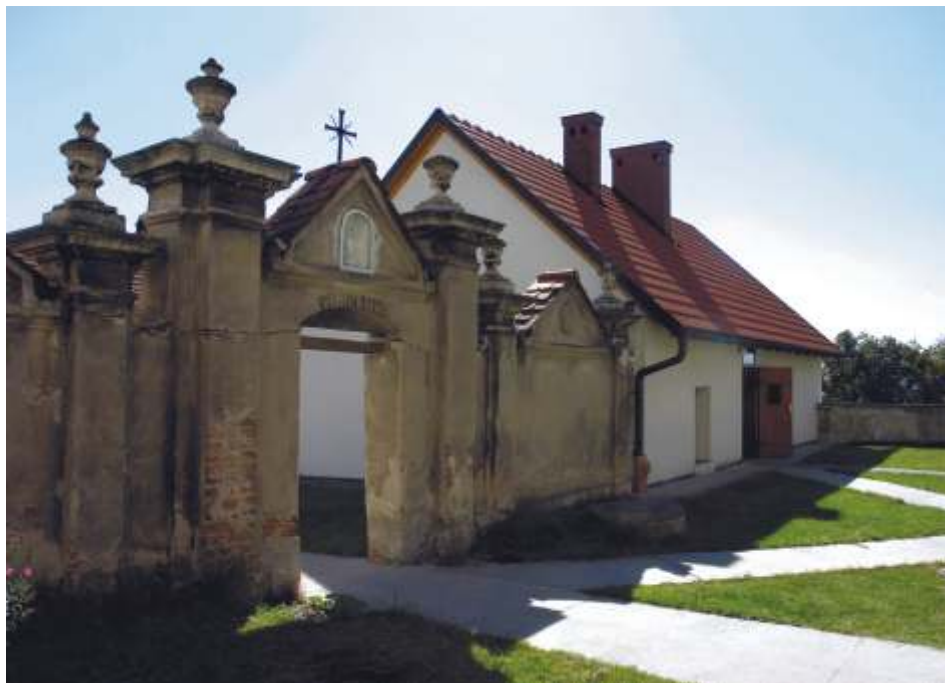
6. Zabudowania gospodarcze w zespole klasztornym oo. Kamedułów na Bielanych wymagające podjęcia prac remontowo-konserwatorskich (fot. Anna Kaczmarz)
