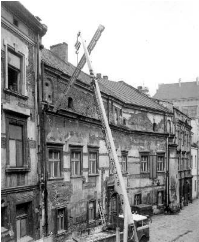
Ul. Kanonicza 18. Pałac Jana Andrzeja de Valentinis z Ferrary, stan w trakcie prac konserwatorskich (Tomasz Kalarus)
