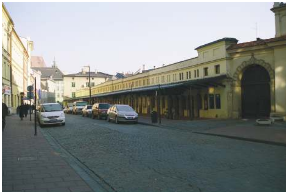
Widok na odrestaurowane kramy dominikańskie przy ul. Stolarskiej (Michał Grychowski)
