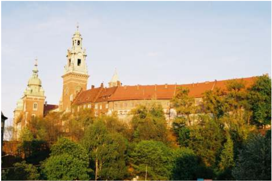
Wawel. Nowe pokrycia dachów budynku nr 7 powstałego z połączenia trzech średniowiecznych budynków (archiwum PRZ)
