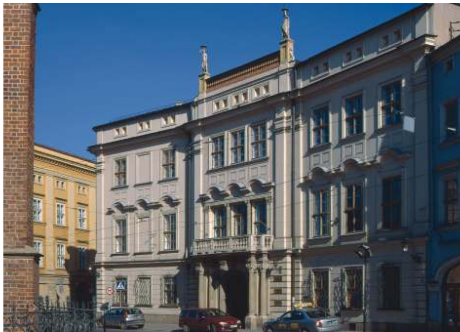
7. Odnowiona elewacja Pałacu Larischa – siedziba Wydziału Prawa i Adm. UJ
