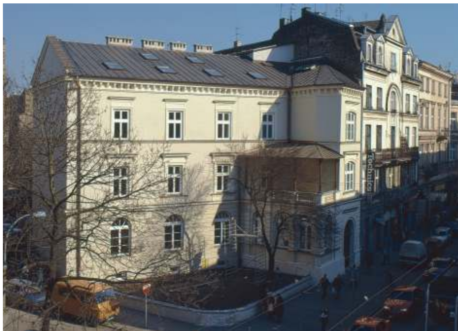
17. Obiekt Akademii Pedagogicznej – ul. Karmelicka 41 po remoncie konserwatorskim
