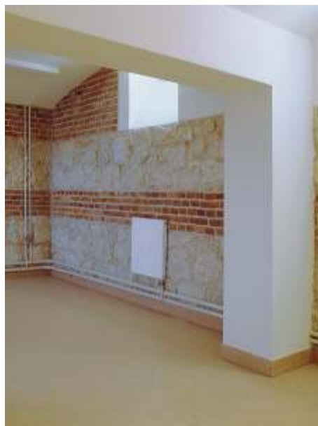
9. Zaadaptowane do współczesnych potrzeb piwnice „Księżówki” – jednego z obiektów Akademii Ekonomicznej
