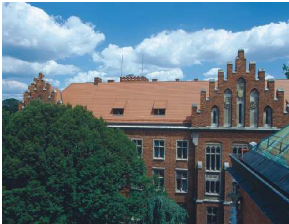
9. Nowy dach na budynku Collegium Witkowskiego UJ.
