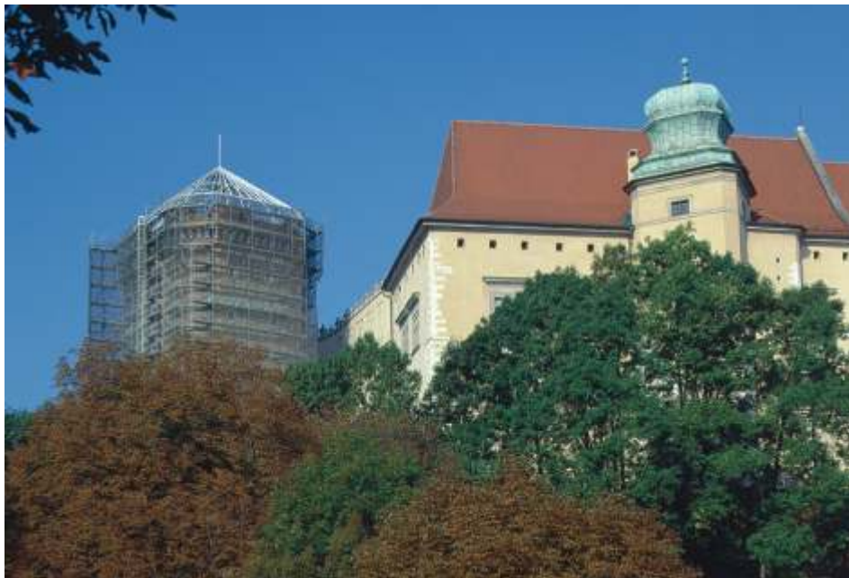
3. Wawel. Baszta Senatorska w trakcie prac rekonstrukcyjnych i renowacyjnych.
